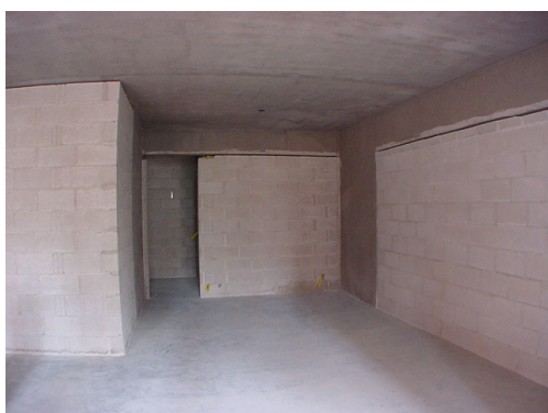
FOTO 5: ALVENARIA INTERNA, EXECUTADA COM BLOCOS DE CONCRETO, ONDE AINDA SERÁ EXECUTADO O SERVIÇO DE FIXAÇÃO DA ALVENARIA.
