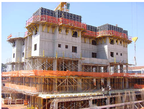
FOTO 9: PAREDES EXTERNAS EM CONCRETO MOLDADO “IN LOCO” (ESTRUTURA E VEDAÇÃO EXTERNA).
