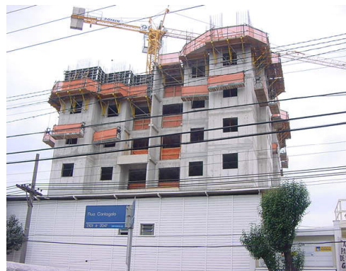
FOTO 10: EXECUÇÃO DE “MEIO ANDAR” DAS PAREDES EXTERNAS EM CONCRETO ARMADO MOLDADO “IN LOCO” DE UM PAVIMENTO TIPO.
