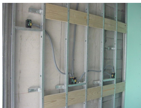
FOTO 14: REFORÇOS DE MADEIRA E INSTALAÇÕES EXECUTADOS INTERNAMENTE ÀS PLACAS DE GESSO ACARTONADO PARA FIXAÇÃO DE BANCAS E ARMÁRIOS.
