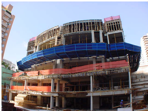
FOTO 1: EXECUÇÃO DA ESTRUTURA UTILIZANDO SISTEMA COM PILARES, VIGAS E LAJES.
