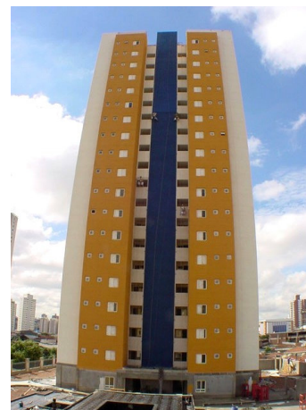
FOTO 16: O EDIFÍCIO EM FASE DA PINTURA DA FACHADA SENDO FINALIZADA.
