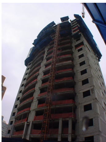
FOTO 3: VEDAÇÕES EXTERNAS EXECUTADAS COM BLOCOS DE CONCRETO.
