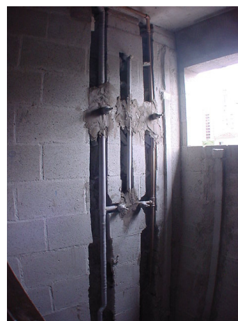
FOTO 4: INSTALAÇÕES HIDRÁULICAS EXECUTADAS COM A UTILIZAÇÃO DE TUBULAÇÃO RÍGIDA, EMBUTIDAS NAS ALVENARIAS.
