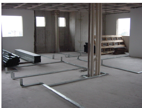
FOTO 13: INTERIOR DE UM PAVIMENTO TIPO, COM INÍCIO DA EXECUÇÃO DAS VEDAÇÕES INTERNAS EM GESSO ACARTONADO.
