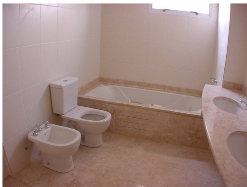
FOTO 7: ACABAMENTO DO BANHEIRO, SEM A UTILIZAÇÃO DE "SHAFT'S" REMOVÍVEIS.
