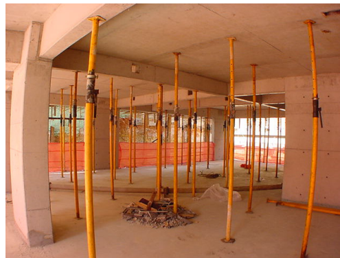
FOTO 2: RE-ESCORAMENTO METÁLICO UTILIZADO NAS LAJES.
