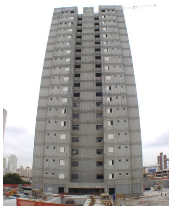
FOTO 15: EMPREENDIMENTO COM ESTRUTURA E ESQUADRIAS FASE DE EXECUÇÃO.
