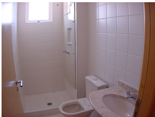
FOTO 17: “SHAFT” DE FIBRA REMOVÍVEL, INSTALADO SOBRE AS PRUMADAS DE TUBULAÇÕES HIDRO-SANITÁRIAS.
