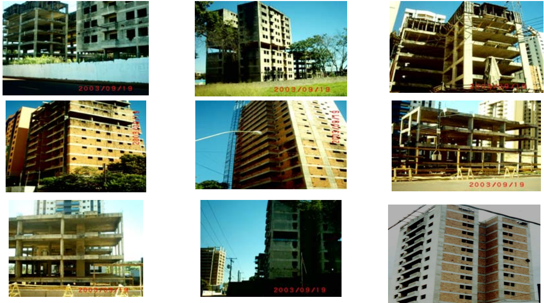
Figura 4.1 Fotos dos edifícios em concreto armado com construção interrompida
