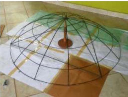
Foto armação da calota elipsoide
