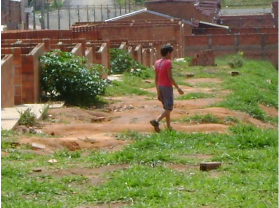
Foto 8 – Criança brincando na obra
