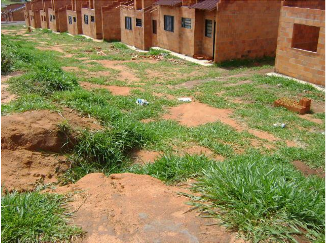
Foto 12 – Visão anterior da obra em construção
