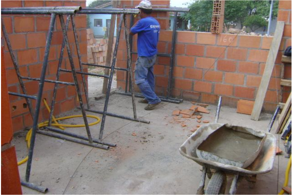
Foto 17 – pedreiro montando o próprio andaime
