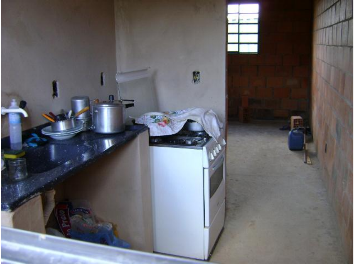
Foto 15 – cozinha do alojamento
