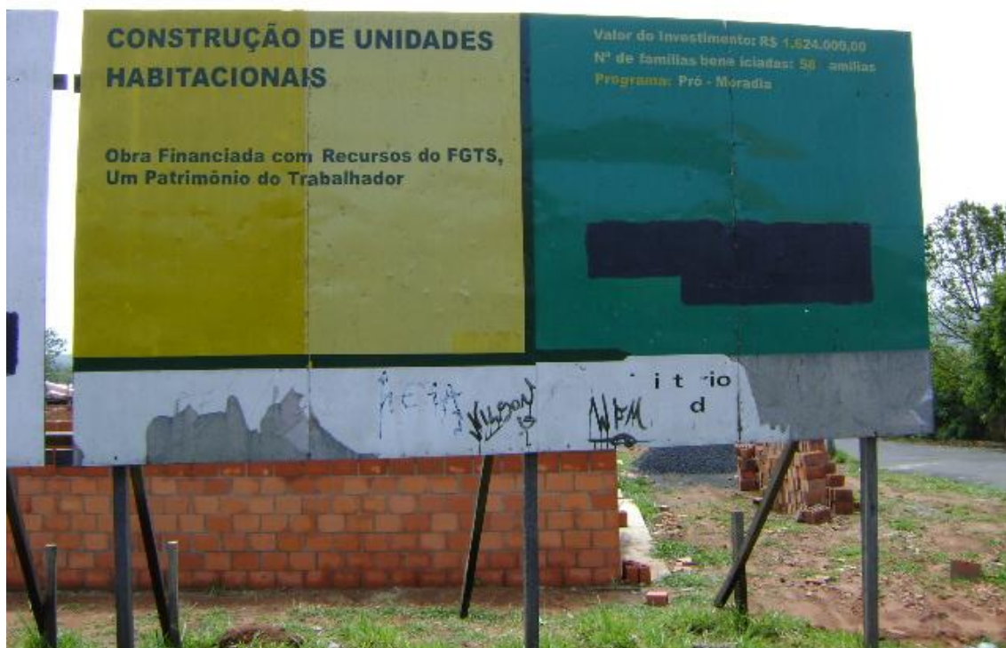
Foto 10 – Placa com dados sobre a construção
