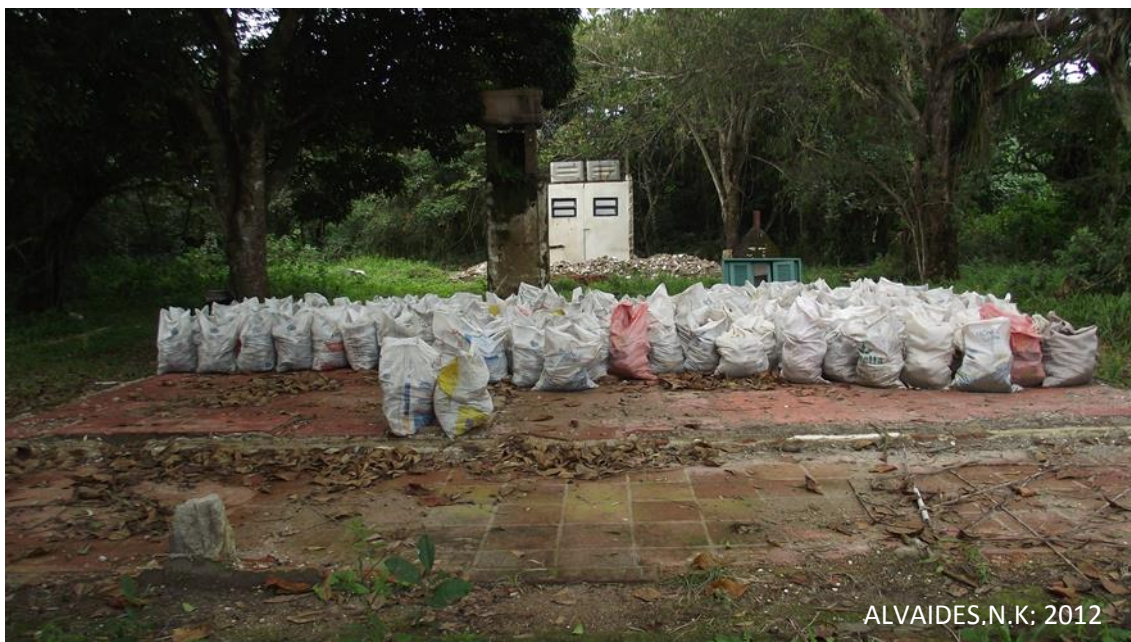
Casa demolida na comunidade do Marujá – PEIC
