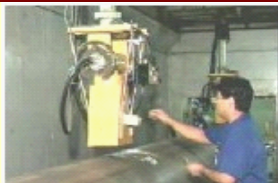
Inspecção radiográfica de soldas em tubos
