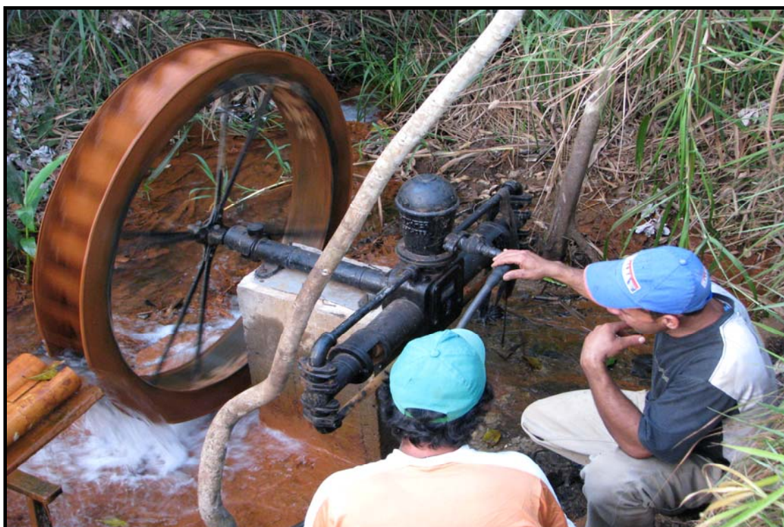
Figura 02 - Primeira experiência com roda d' água instalada no núcleo Che Guevara.
