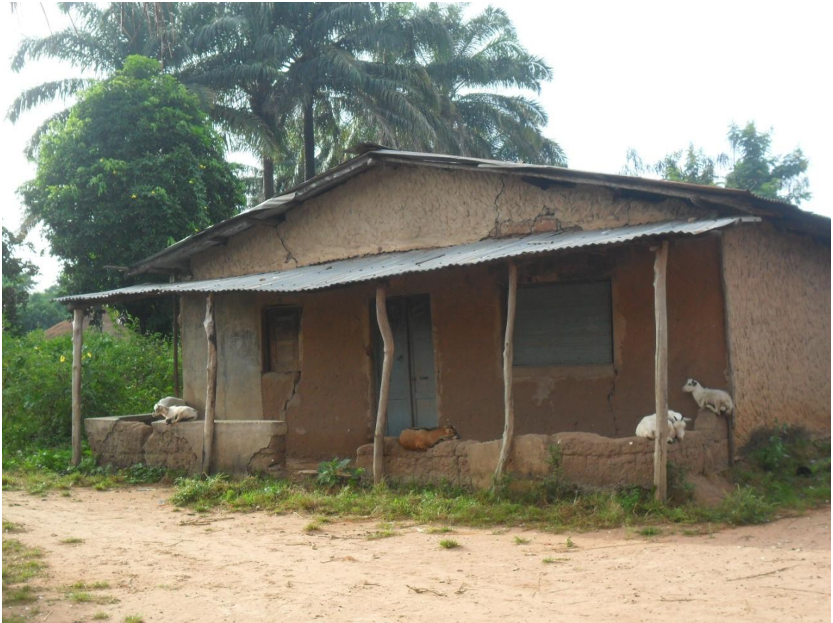
Foto 9. Legenda: Casa na tabanca de Ambô. Uma casa com arquitetura diferente das demais casas tradicionais Bijagó. Com acabamento de cimento e cobertura de zinco(Fonte: SANTY, B. outubro, 2011).
