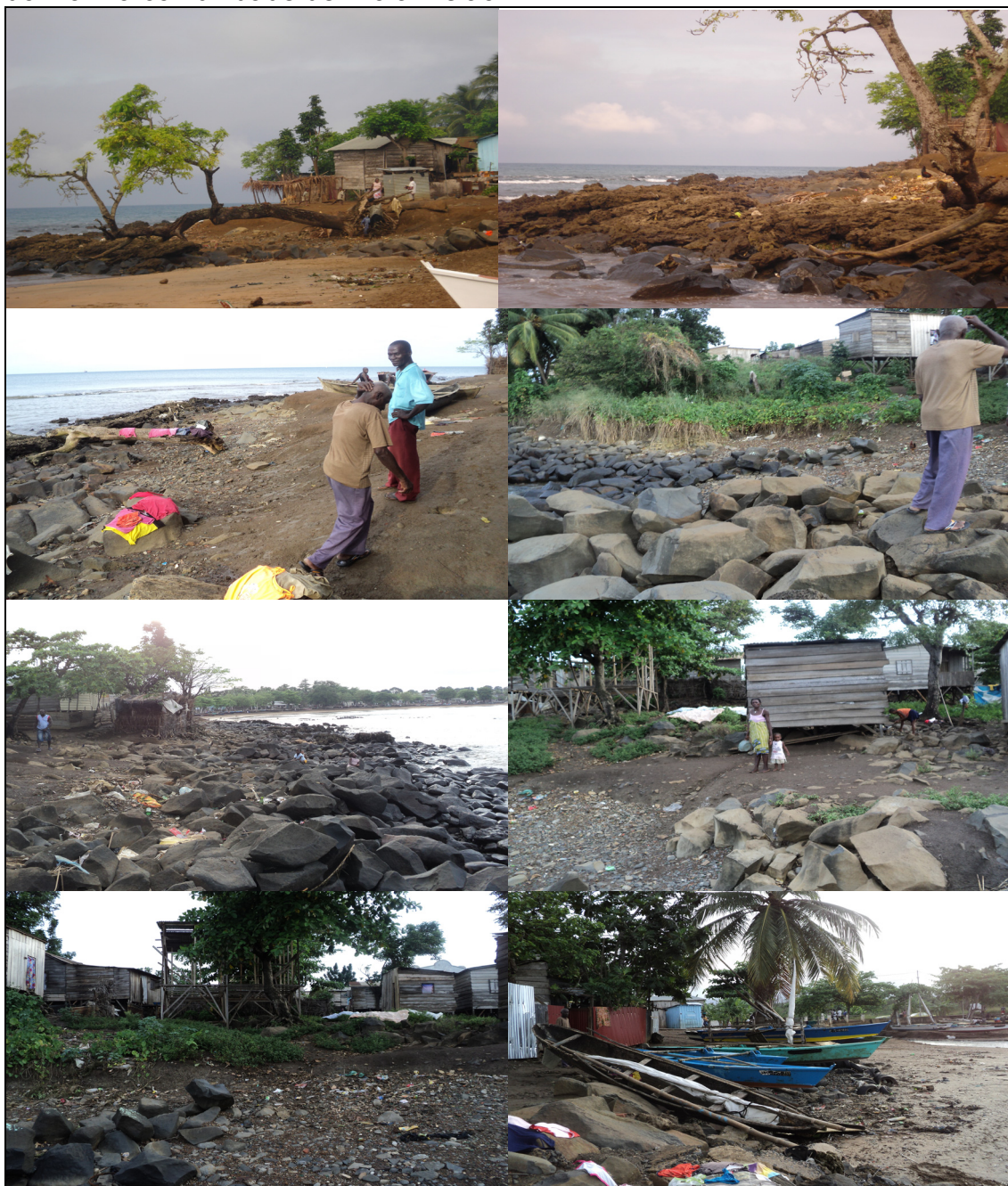
Figura 13 – Crescente e rápida erosão costeira em decorrência da subida do nível do mar na comunidade de Praia Melão
