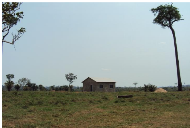
Figura 14 – Casa não terminada
