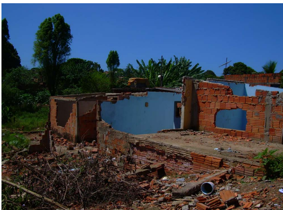
Foto 10 – Uma das casas do Núcleo São João que foi demolida e família foi direcionada para as casas da Cohab, via financiamento
