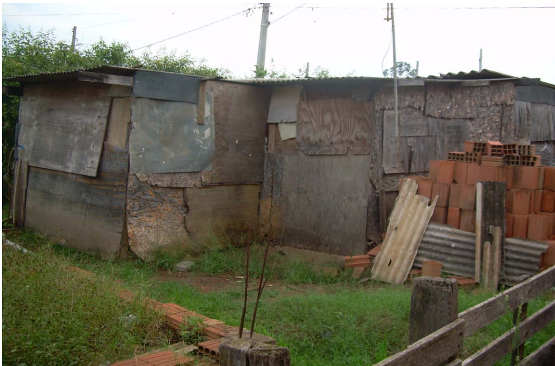
Foto 6 – Barraco no Campo Belo I
