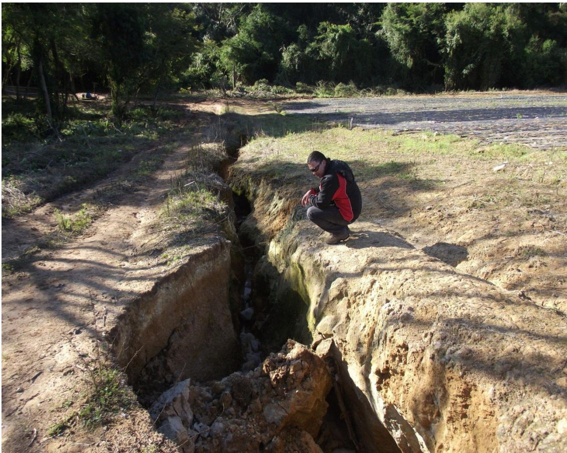
Figura 22: Processo erosivo em estado avançado, propriedade agrícola da Microbacia do rio Piraporinha.
