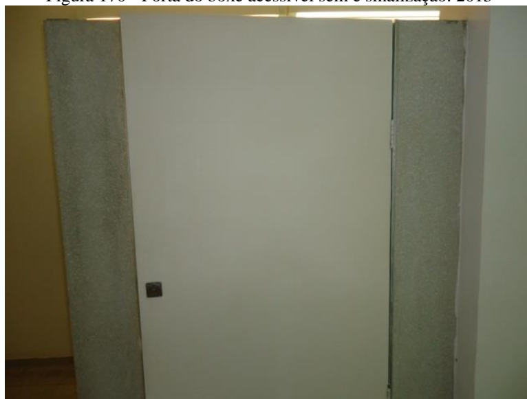
Figura 170 - Porta do boxe acessível sem e sinalização. 2013
