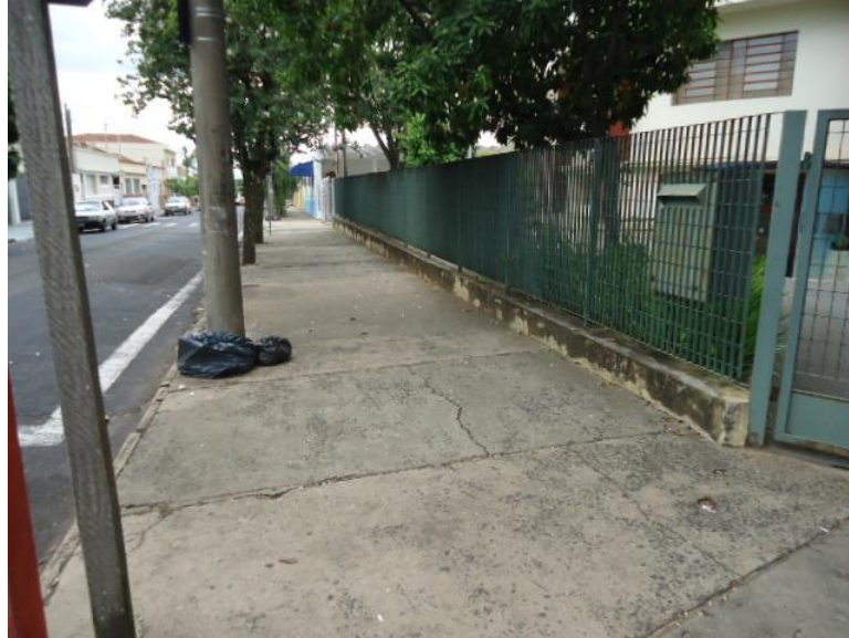
Figura 57 - Passeio público margeando a Rua Antônio de Almeida Leite. 2013
