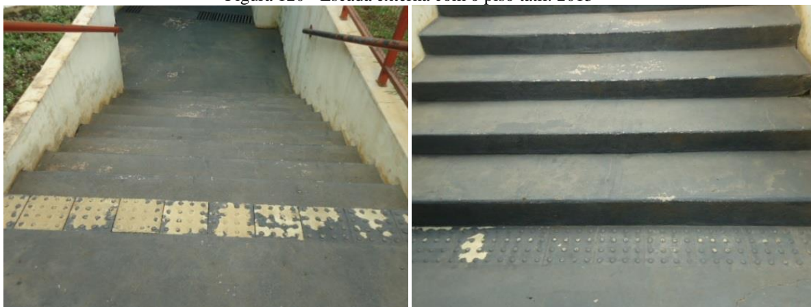
Figura 120 - Escada externa com o piso tátil. 2013
