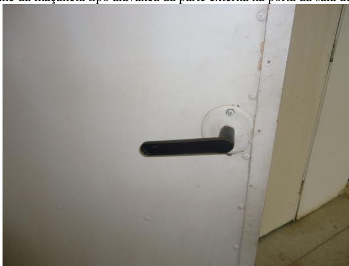
Figura 104- Detalhe da maçaneta tipo alavanca da parte externa na porta da sala de espetáculos. 2013
