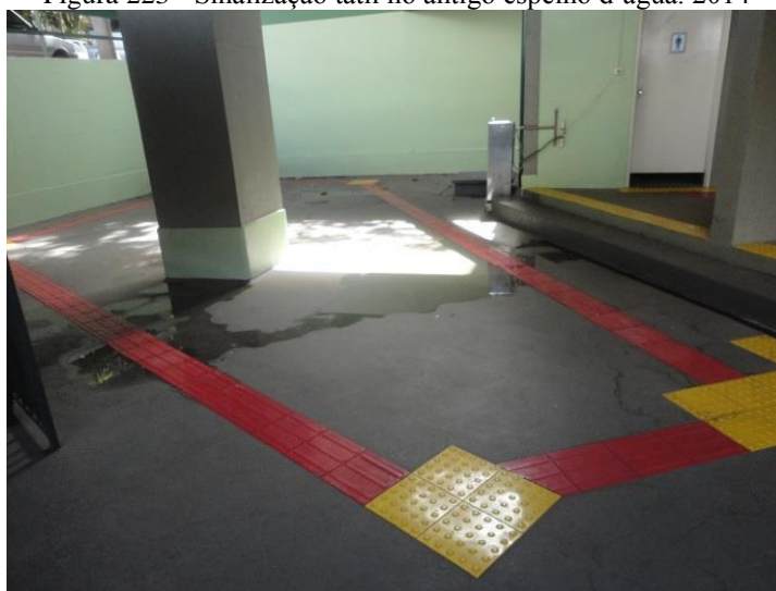
Figura 223 - Sinalização tátil no antigo espelho d'água. 2014
