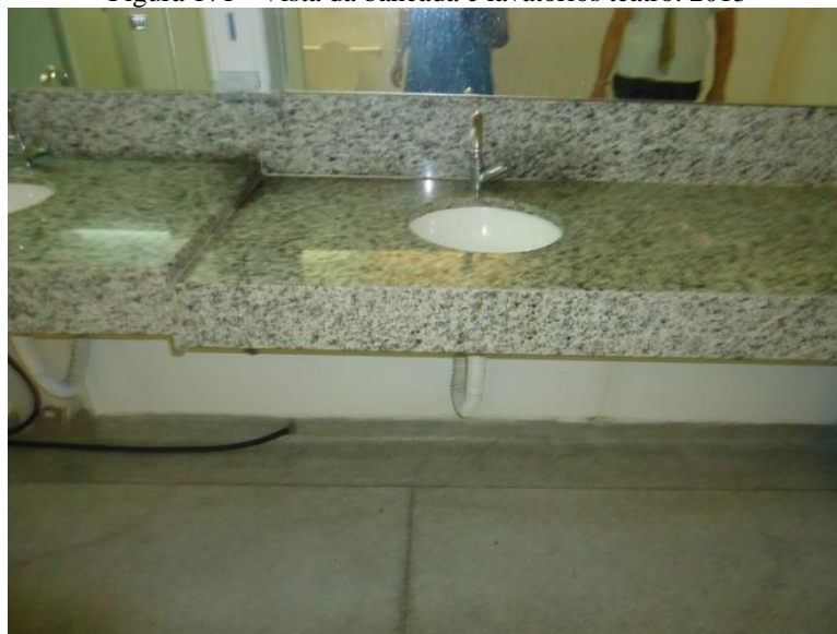
Figura 171 - Vista da bancada e lavatórios teatro. 2013
