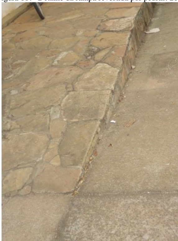
Figura 107- Detalhe da rampa revestida por pedras. 2013
