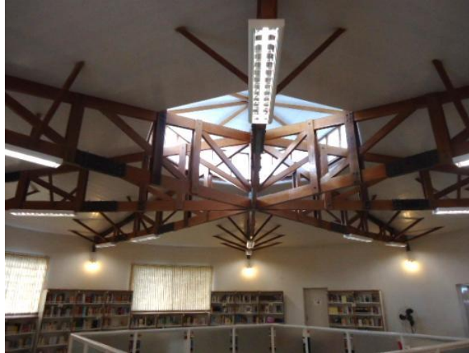
Figura 30 - Estrutura em madeira de peroba rosa e lanternim. 2013
