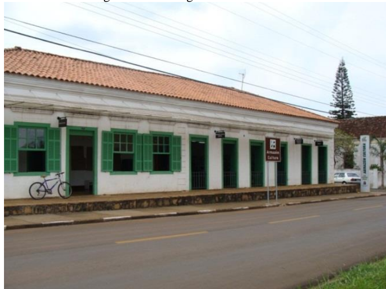
Figura 69 - Vista geral da fachada.2013
