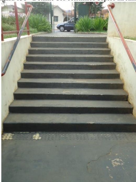
Figura 138 - Detalhe dos corrimãos duplos na rampa
