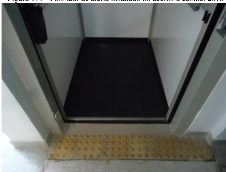
Figura 179 - Piso tátil de alerta instalado no acesso a cabine. 2013
