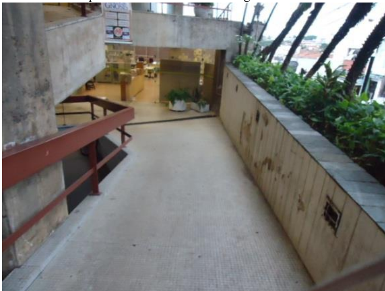
Figura 134 - Guarda corpo unilateral instalado sobre guia de balizamento. 2013
