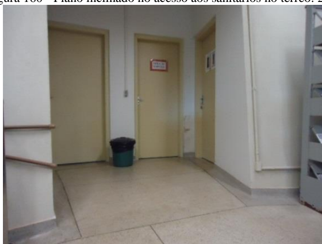
Figura 160 - Plano inclinado no acesso aos sanitários no térreo. 2013
