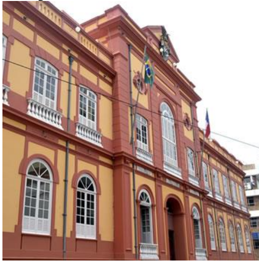
Figura 9 - Vista da fachada da biblioteca
