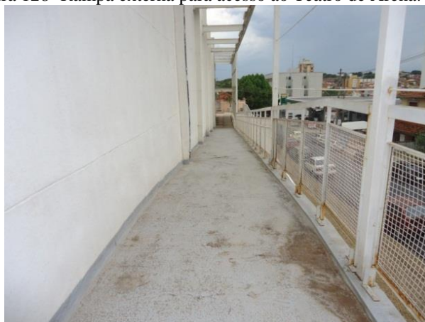
Figura 128- Rampa externa para acesso ao Teatro de Arena. 2013.
