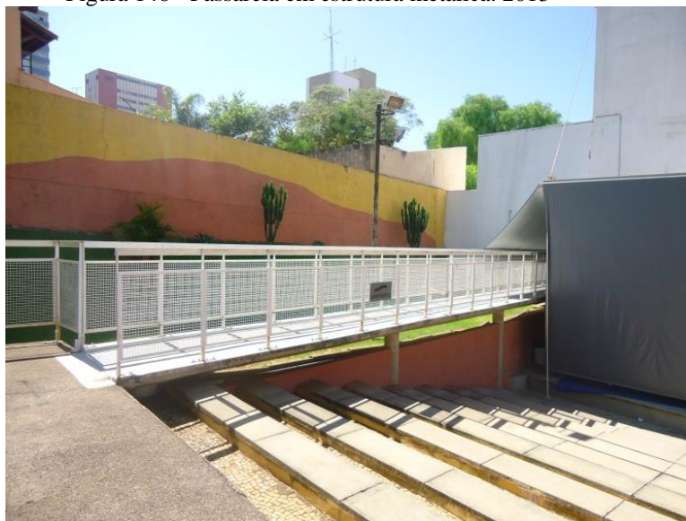
Figura 146 - Passarela em estrutura metálica. 2013
