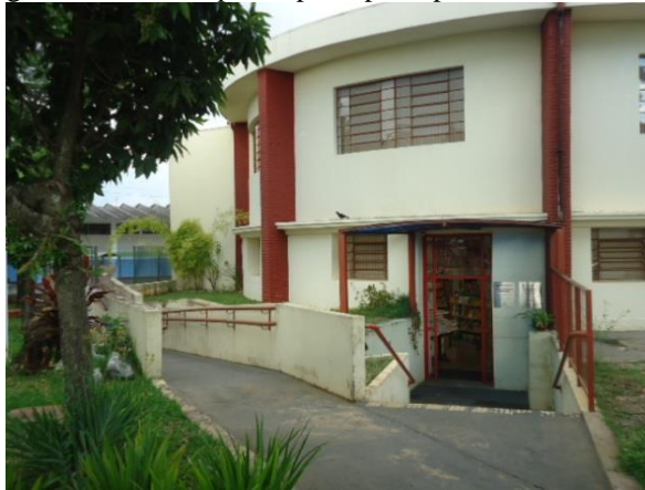
Figura 88- Acessos para a porta principal do edifício. 2013
