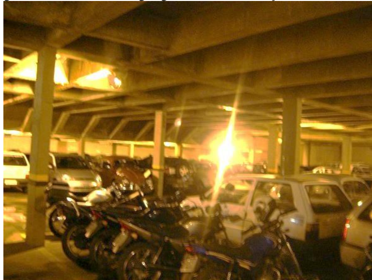
Figura 38 - Vista interna da garagem no subsolo - Praça Coronel Sales 2007
