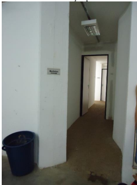
Figura 164 - Plano inclinado e circulação para acesso aos sanitários. 2013
