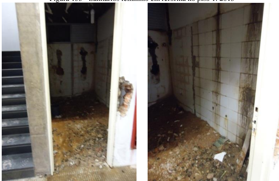
Figura 155 - Sanitários feminino em reforma no piso 1. 2013
