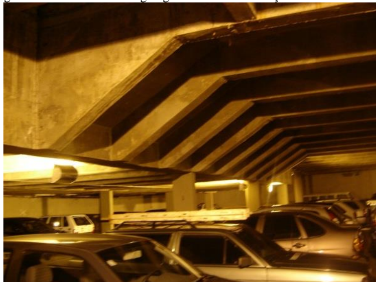
Figura 39 - Vista interna da garagem no subsolo - Praça Coronel Sales 2007
