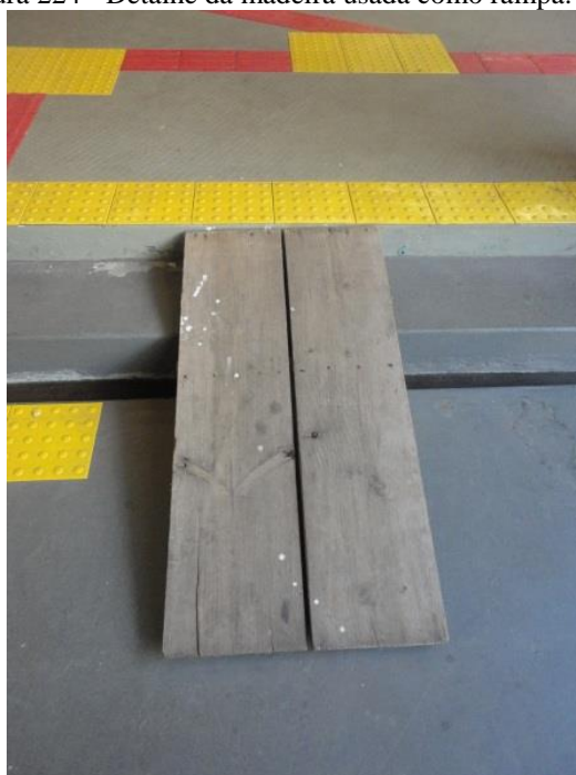
Figura 224 - Detalhe da madeira usada como rampa. 2014
