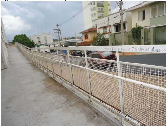
Figura 144 - Guarda Corpo e corrimão na rampa de acesso. 2013
