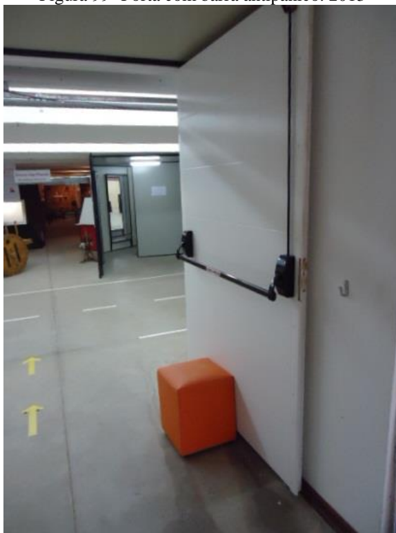
Figura 99- Porta com barra antipânico. 2013
