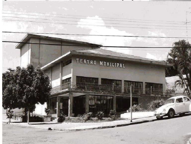
Figura 41 - Vista da fachada do Teatro Municipal pela Rua José Bonifácio
