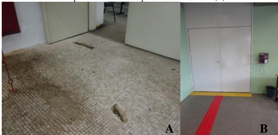
Figura 55 - Piso da área externa revestido com as pastilhas de mármore. 2013 (A) e Piso da área externa com pastilhas de mármore pintadas. Janeiro/2014. (B)
