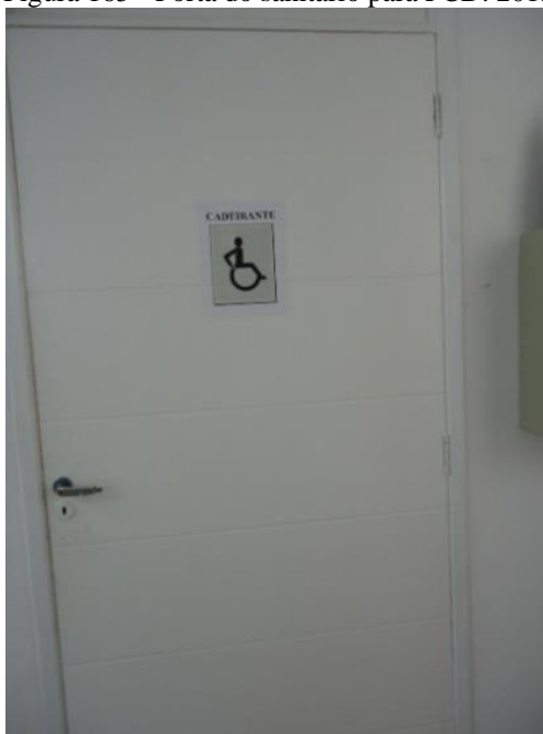
Figura 165 - Porta do sanitário para PCD. 2013
