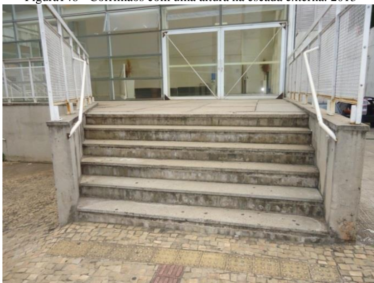
Figura148 - Corrimãos com uma altura na escada externa. 2013
