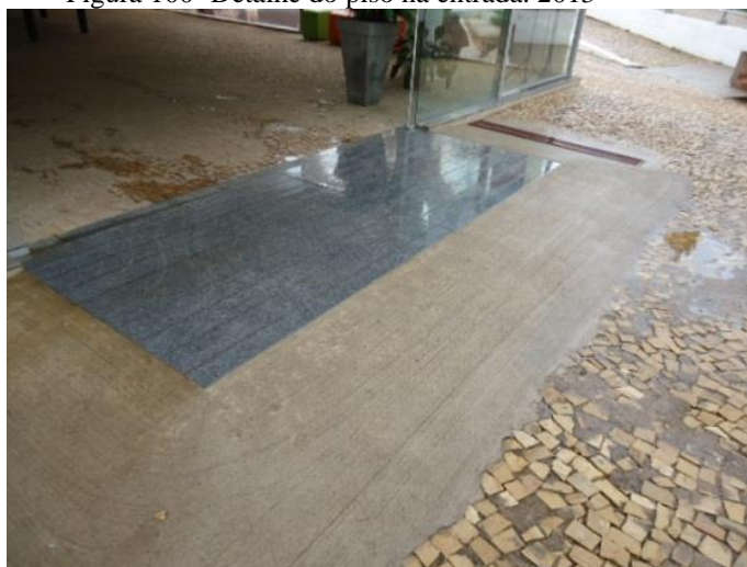
Figura 100- Detalhe do piso na entrada. 2013
