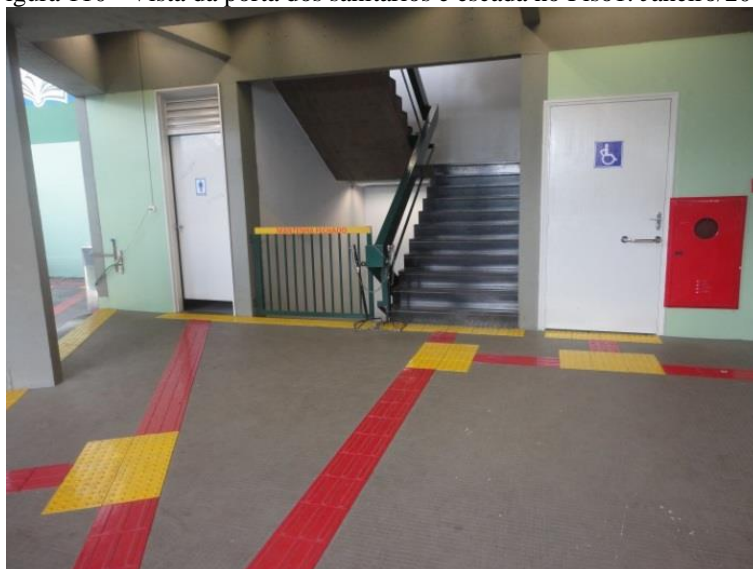
Figura 110 - Vista da porta dos sanitários e escada no Piso1. Janeiro/2014
