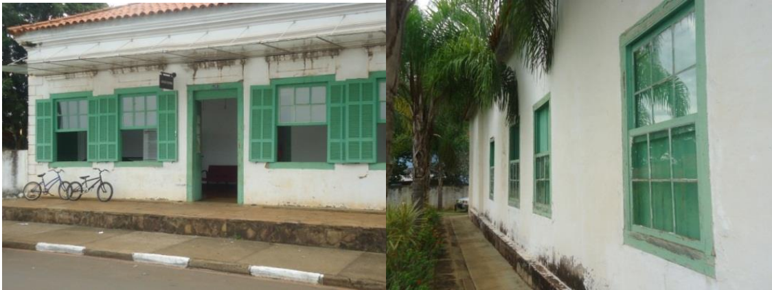
Figura 75 - Vista externa na biblioteca infantil. 2013
