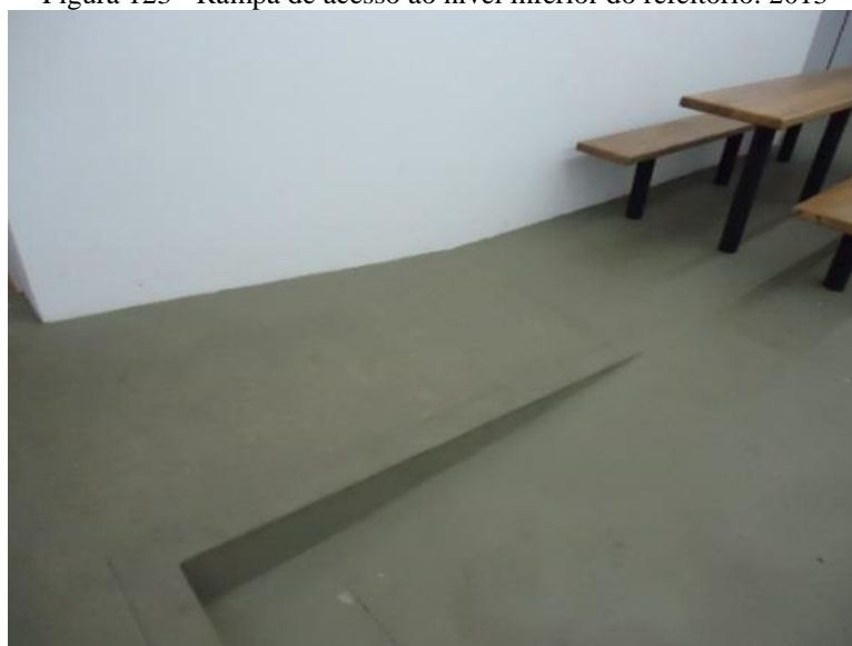
Figura 123 - Rampa de acesso ao nível inferior do refeitório. 2013
