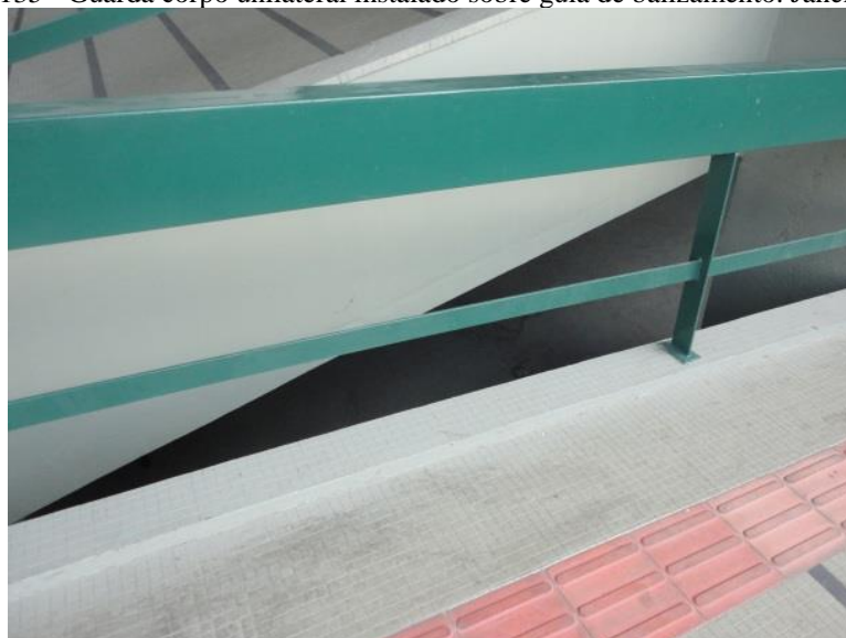
Figura 135 - Guarda corpo unilateral instalado sobre guia de balizamento. Janeiro/2014.
