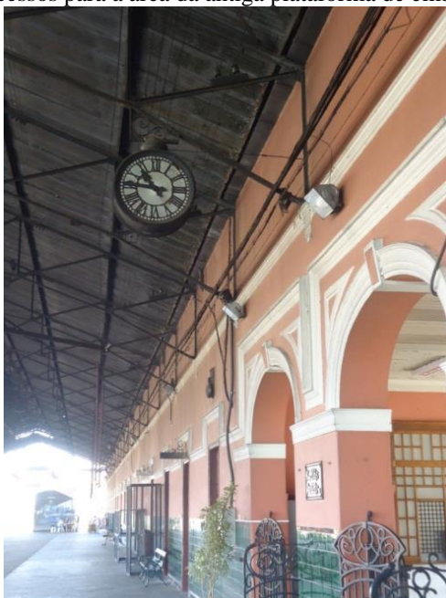
Figura 93- Acessos para a área da antiga plataforma de embarque. 2013
