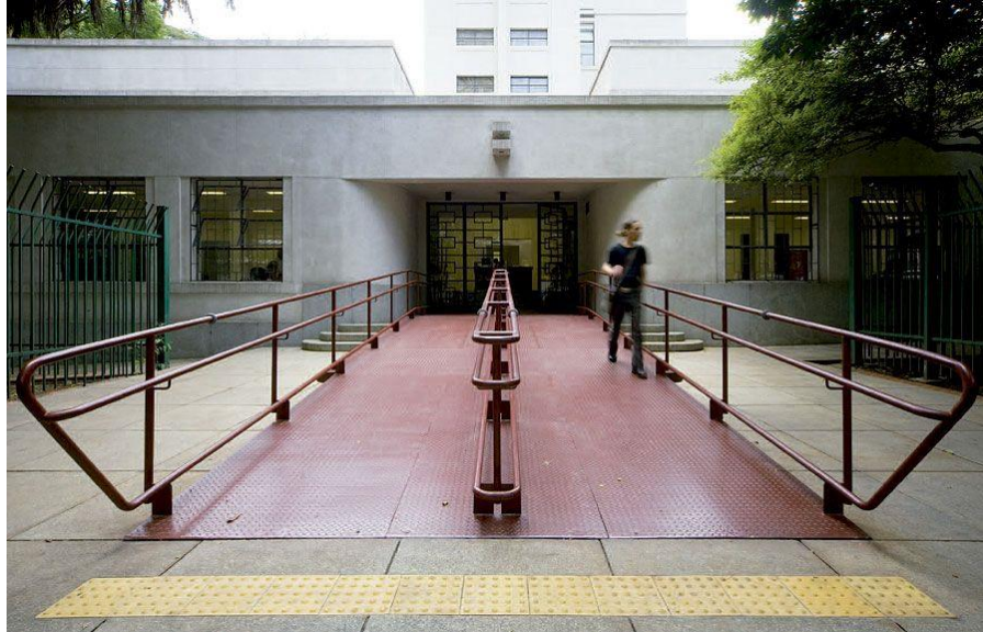
Figura 5 - Entrada da Biblioteca pela Avenida São Luís com corrimãos e sinalização tátil
