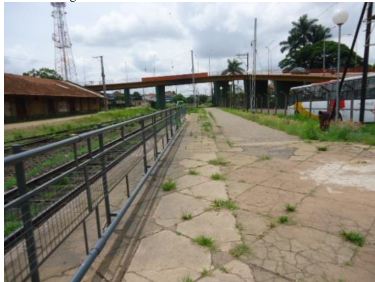
Figura 67 - Piso em concreto da área externa. 2012
