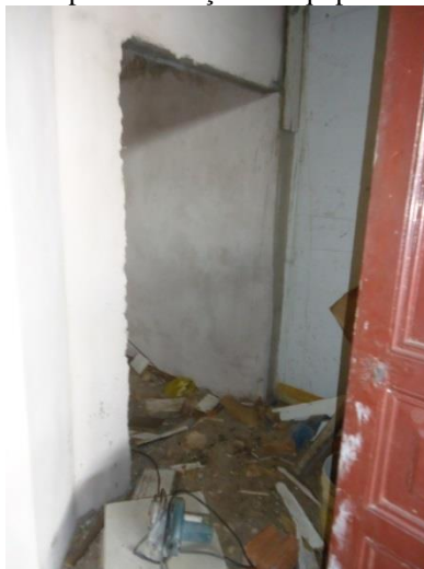
Figura 182 - Reforma para colocação de equipamento eletromecânico.
