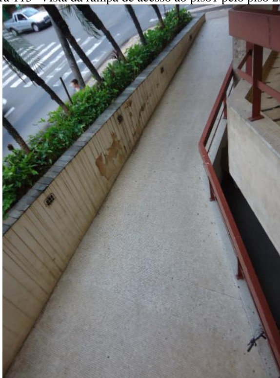
Figura 115- Vista da rampa de acesso ao piso1 pelo piso 2. 2013
