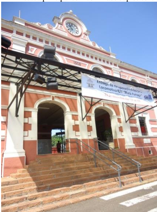
Figura 141 - Escada principal com corrimãos duplos centrais.2013
