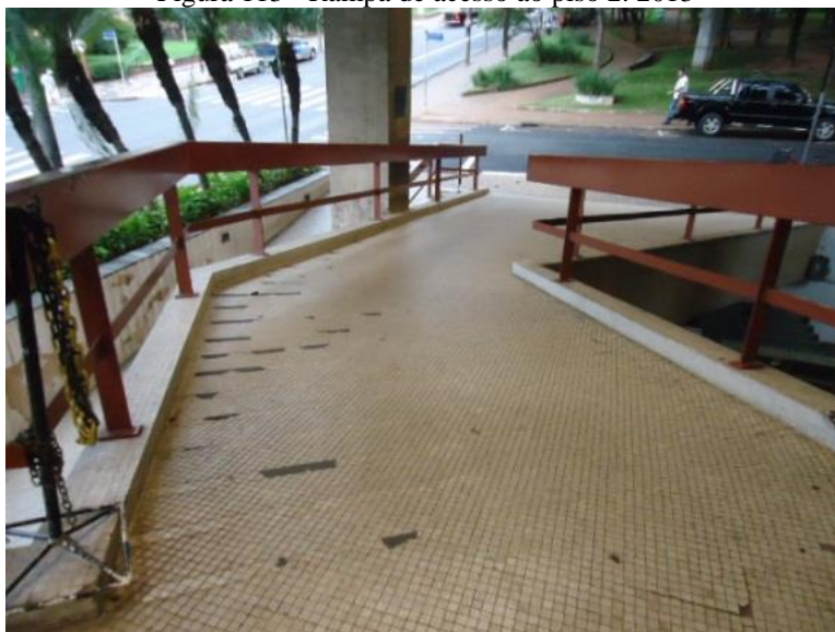
Figura 113 - Rampa de acesso ao piso 2. 2013
