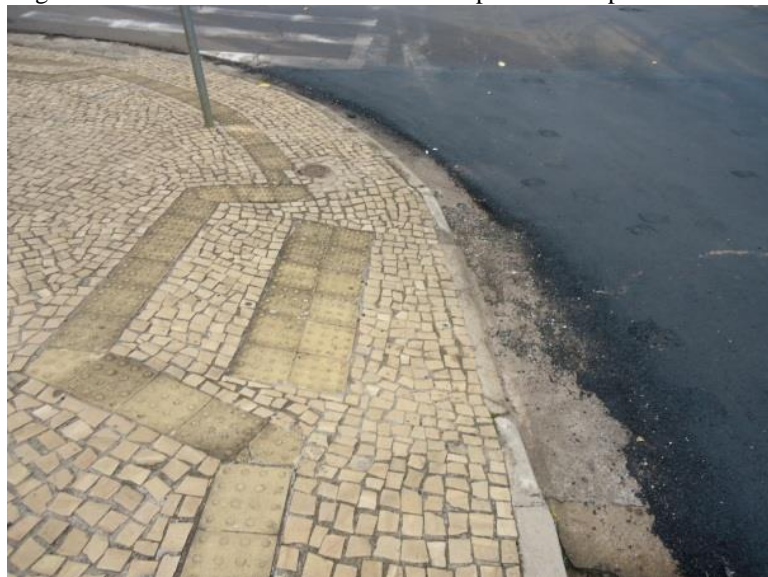
Figura 63 - Mobiliário urbano instalado no percurso do pedestre. 2013.
