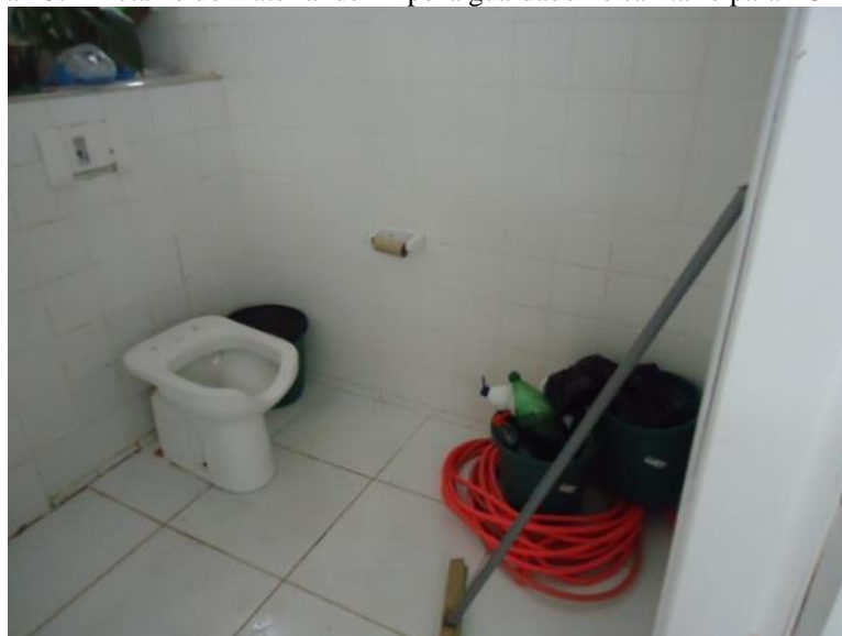
Figura 167 - Detalhe do material de limpeza guardado no sanitário para PCD. 2013
