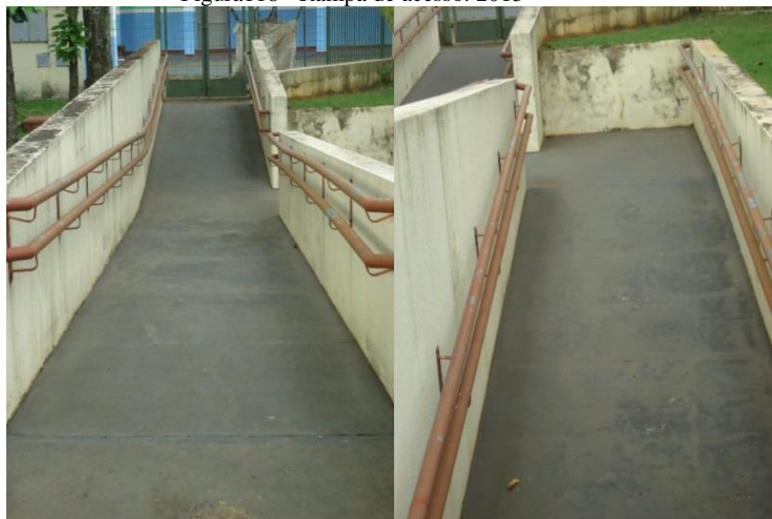
Figura118 - Rampa de acesso. 2013
