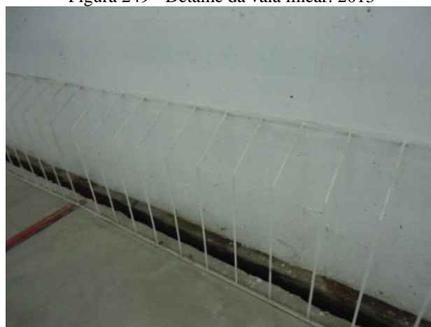
Figura 249 - Detalhe da vala linear. 2013
