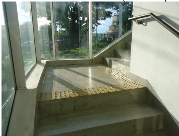
Figura 119 - Patamar na escada interna revestida com granilite e com piso tátil. 2013
