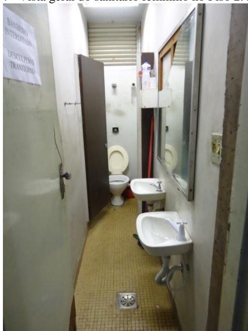
Figura 154 - Vista geral do sanitário feminino no Piso 2. Maio/2013
