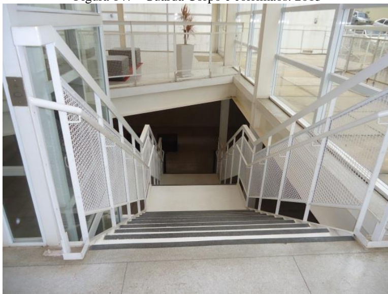
Figura 147 - Guarda Corpo e corrimãos. 2013
