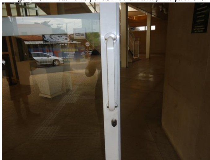
Figura 101- Detalhe do puxador da entrada principal. 2013
