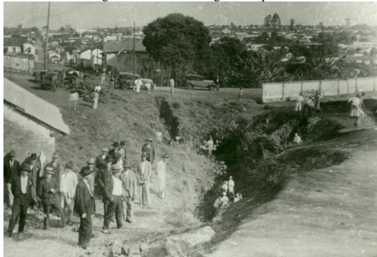
Figura 40 - Vista Córrego da Biquinha
