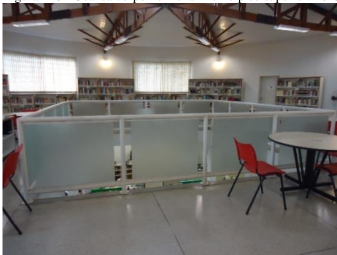
Figura 140 - Guarda corpo no mezanino no piso superior. 2013
