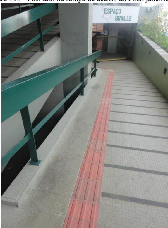
Figura 116 - Piso tátil na rampa de acesso ao Piso. janeiro/2014
