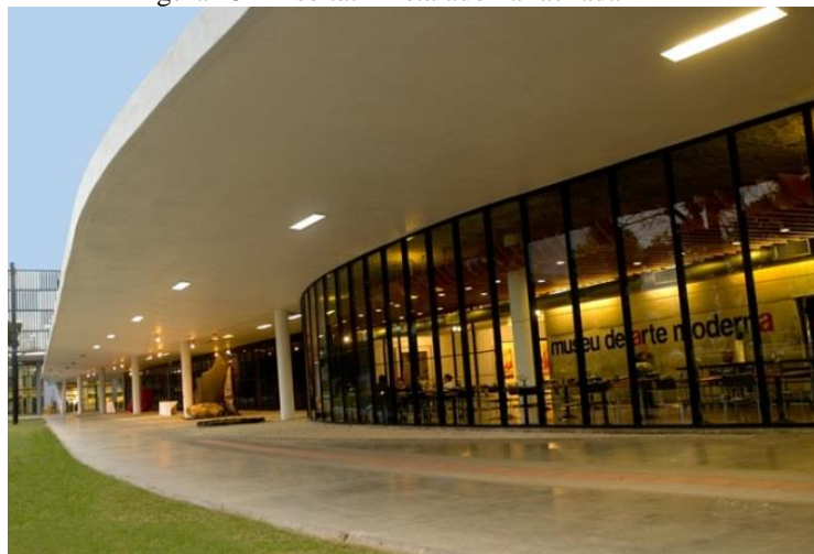
Figura 15 - Piso tátil instalado na fachada MAM
