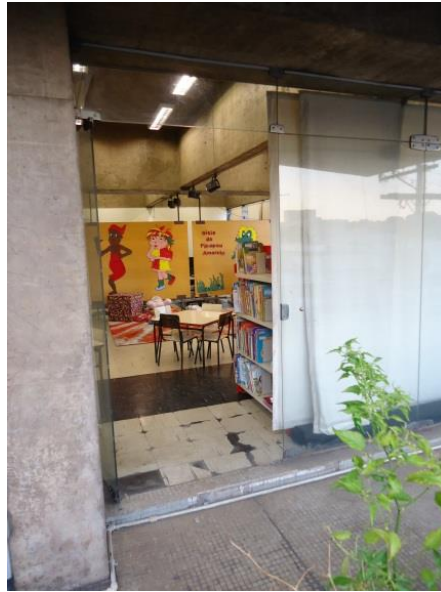
Figura 85- Entrada lateral da biblioteca infantil. 2013
