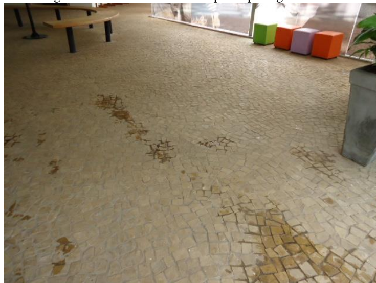
Figura 61 - Piso revestido com pedra portuguesa. 2013
