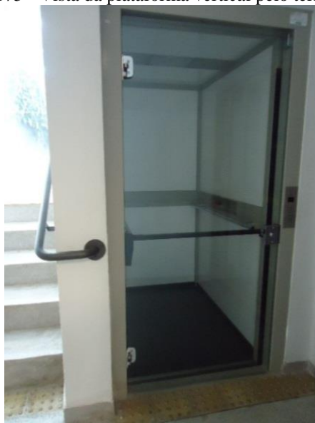
Figura 175 - Vista da plataforma vertical pelo térreo. 2013
