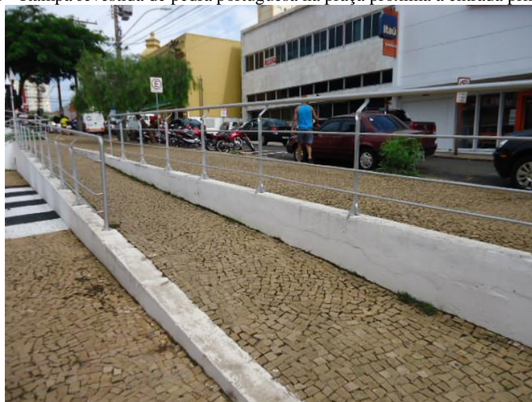
Figura 125 - Rampa revestida de pedra portuguesa na praça próxima a entrada principal. 2013
