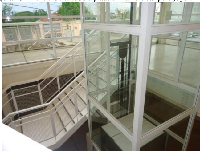
Figura 131 - Vista da escada e plataforma vertical pelo foyer . 2013.
