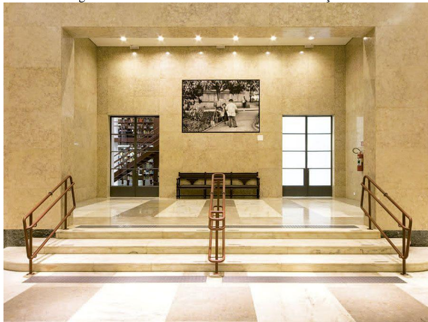
Figura 6 - Corrimãos com duas alturas e sinalização tátil
