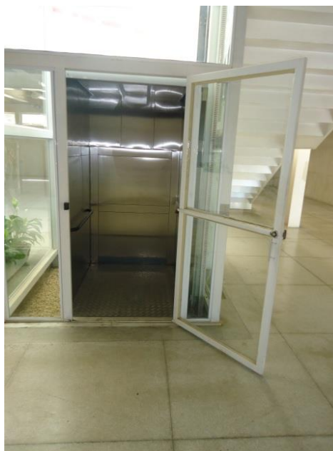
Figura 180 - Vista da plataforma vertical no térreo. 2013
