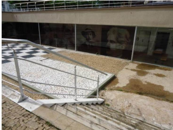
Figura 60 - Vista da escada e parte da fachada. 2013
