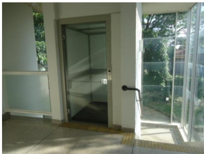
Figura 176 - Vista da plataforma vertical pelo pavimento superior. 2013
