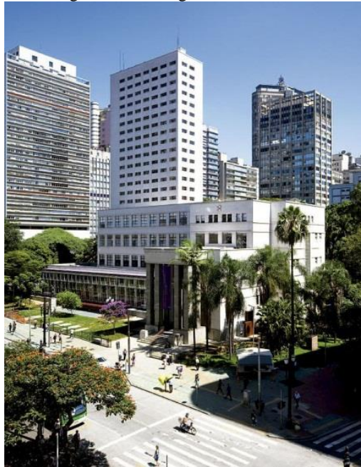
Figura 4 - Vista geral das fachadas
