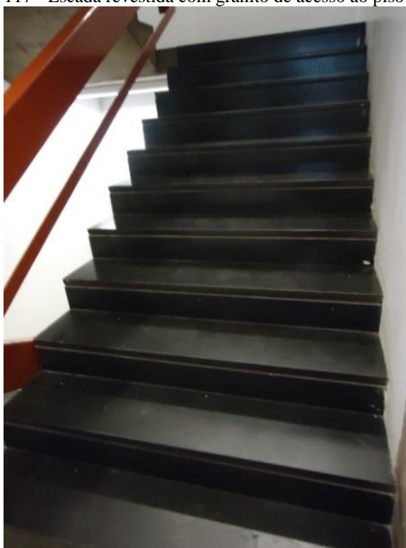
Figura 117 - Escada revestida com granito de acesso ao piso 3. 2013
