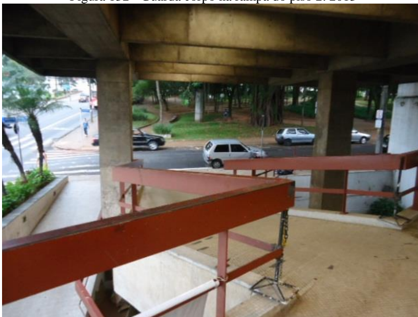
Figura 132 - Guarda corpo na rampa do piso 2. 2013
