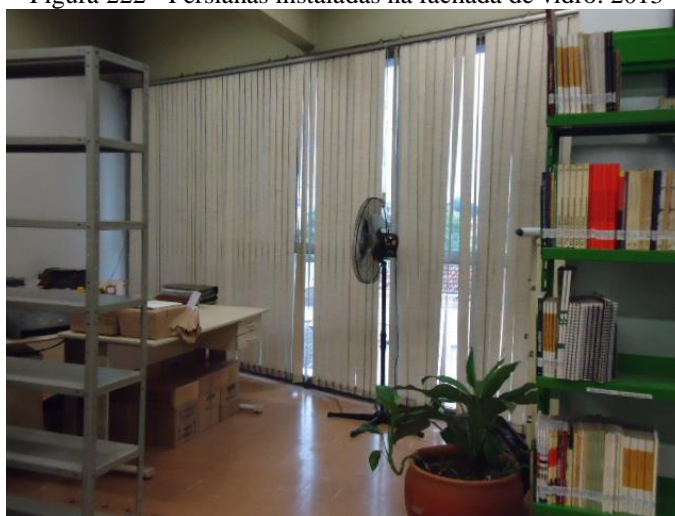
Figura 222 - Persianas instaladas na fachada de vidro. 2013
