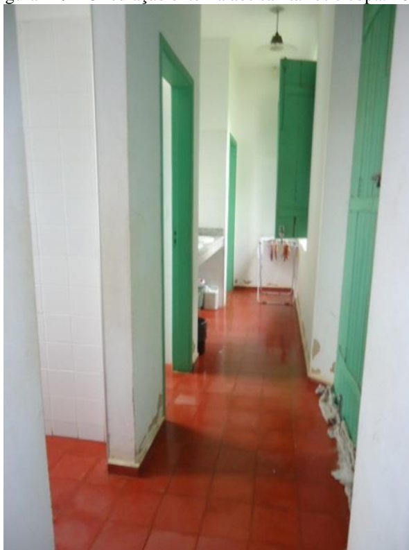
Figura 149 - Circulação externa aos sanitários e copa. 2013
