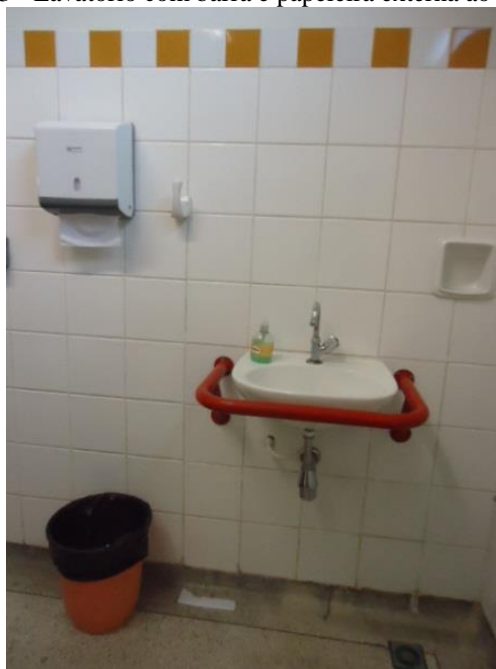
Figura 163 - Lavatório com barra e papeleira externa ao boxe. 2013
