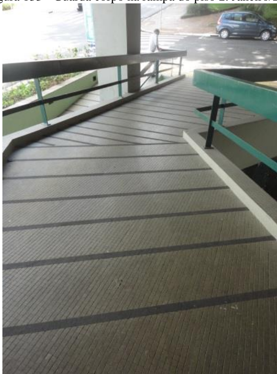
Figura 133 - Guarda corpo na rampa do piso 2. Janeiro/2014
