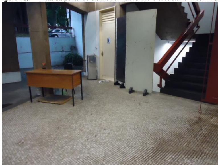
Figura 109 - Vista da porta do banheiro masculino e escada no Piso1. 2013
