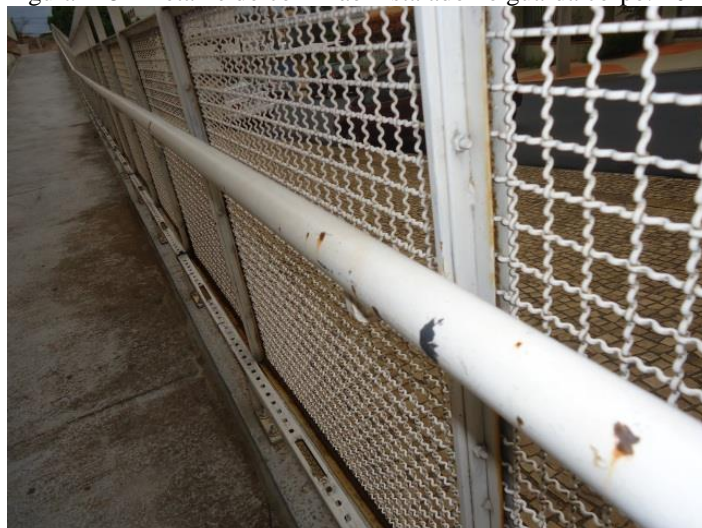
Figura 145 - Detalhe do corrimão instalado no guarda corpo. 2013
