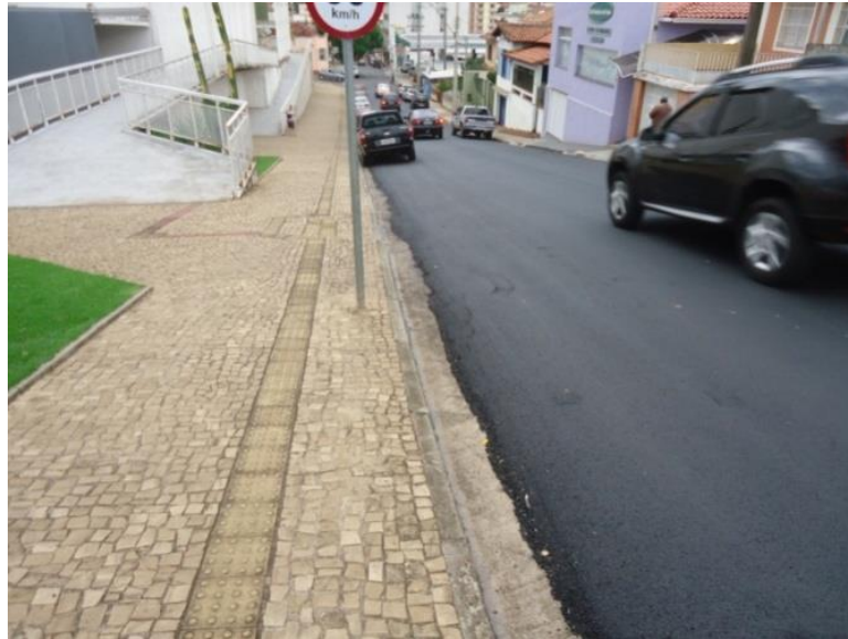
Figura 49 - Vaga não sinalizada horizontalmente
