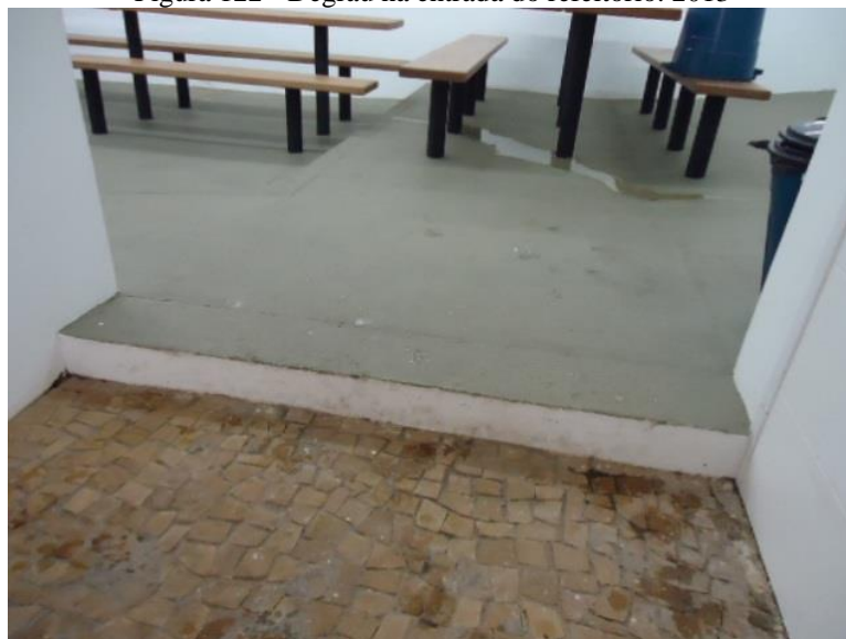
Figura 122 - Degrau na entrada do refeitório. 2013
