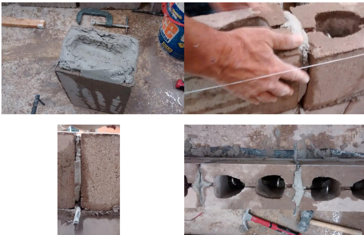
Figura 35 - Execução da Alvenaria e Grauteamento
