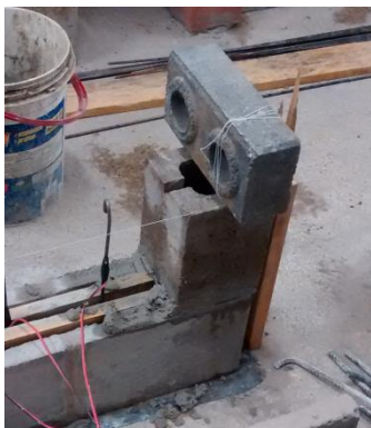
Figura 34 - Execução da Alvenaria e Grauteamento
