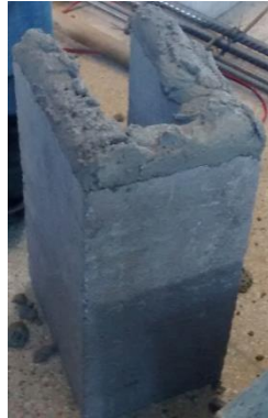
Figura 31 - Execução da Alvenaria e Grauteamento
