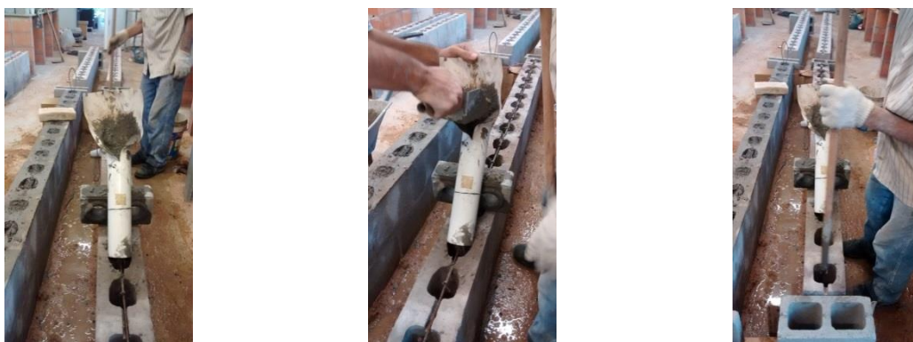
Figura 37 - Execução da Alvenaria e Grauteamento
