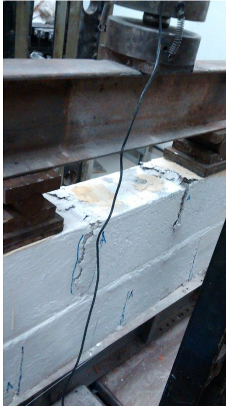
Figura 74 - Destacamento na Região próximo da Carga
