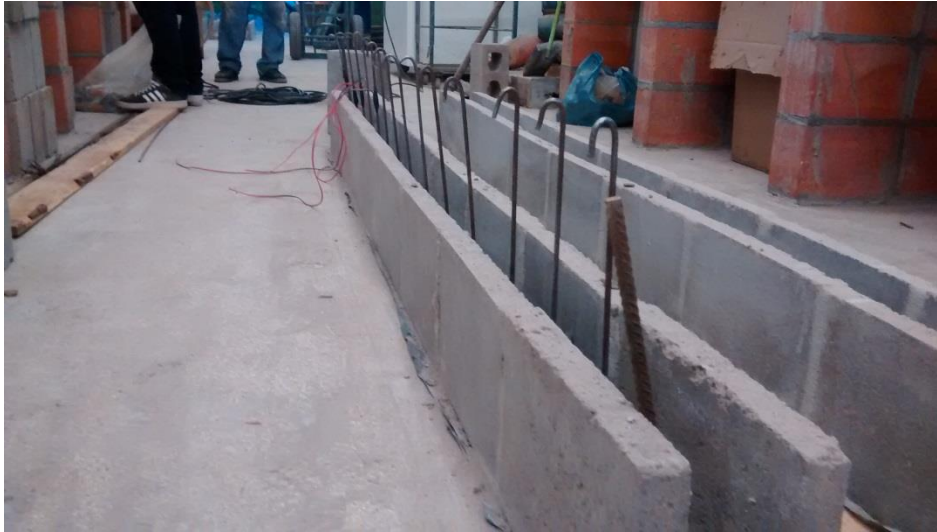
Figura 33 - Execução da Alvenaria e Grauteamento
