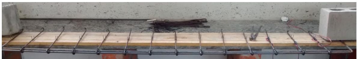
Figura 26 - Amarração da Armadura Longitudinal
