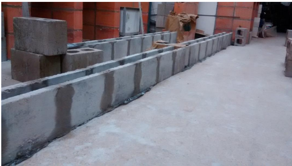
Figura 32 - Execução da Alvenaria e Grauteamento
