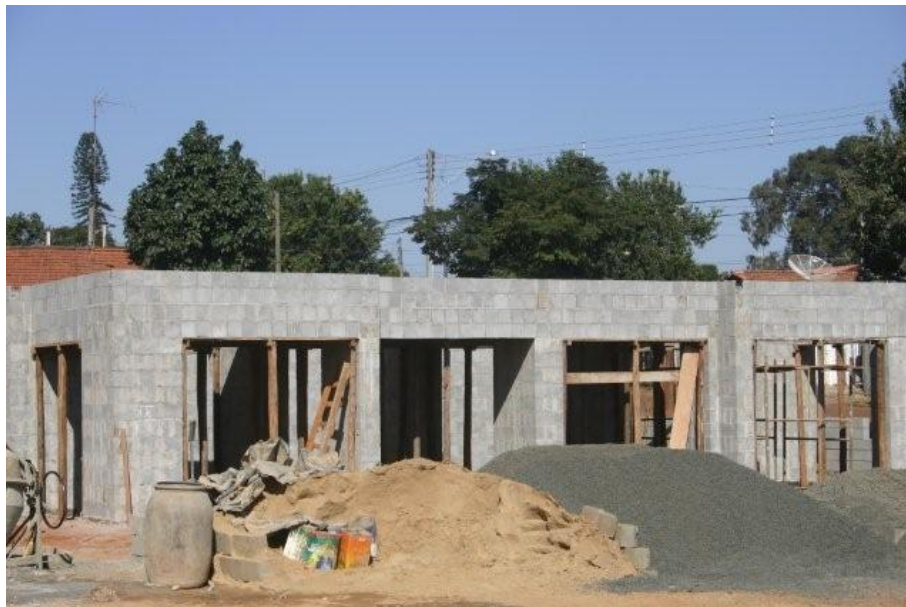
Figura 5- Exemplo de Viga de Alvenaria
