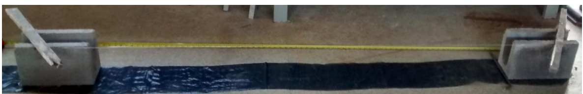
Figura 30 - Execução da Alvenaria e Grauteamento
