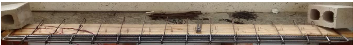
Figura 28 - Amarração da Armadura Longitudinal
