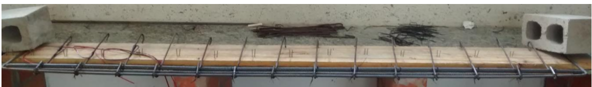
Figura 27 - Amarração da Armadura Longitudinal
