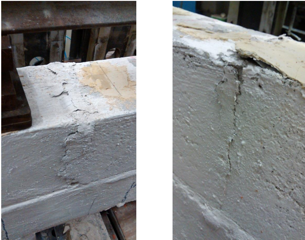
Figura 73 - Estufamento e Fissura na Junta
