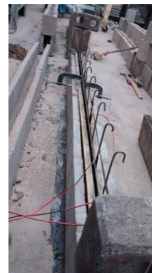
Figura 34 - Execução da Alvenaria e Grauteamento
