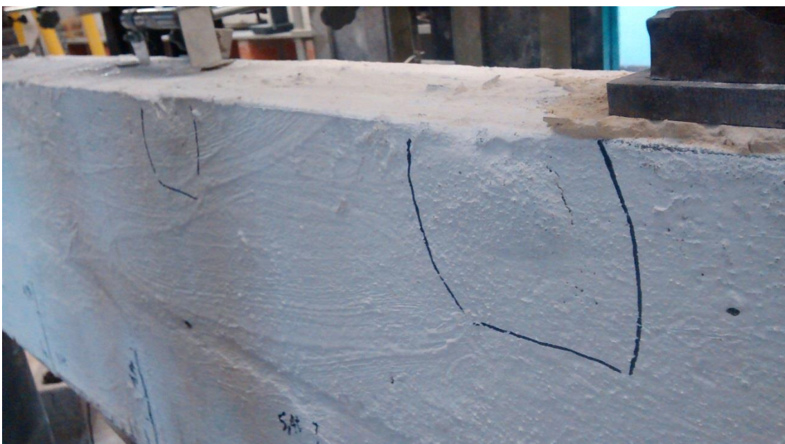
Figura 81 - Descascamento do Bloco
