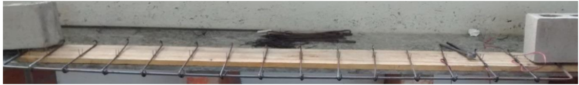
Figura 25 - Amarração da Armadura Longitudinal
