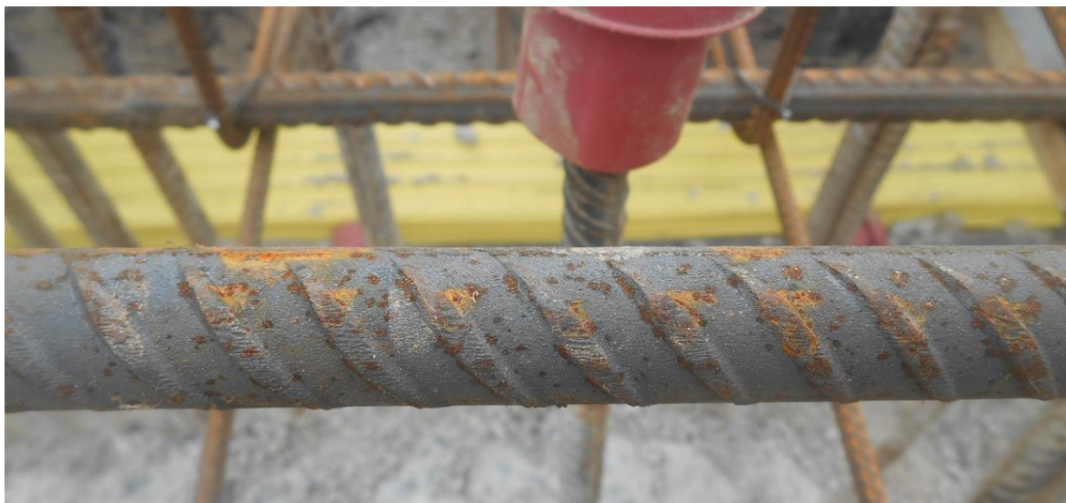
Figura 35 – Detalhe de uma barra de aço \phi 25 mm e suas nervuras
