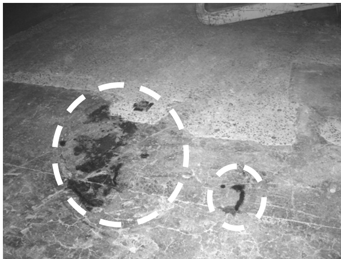
Figura 5.20: Água condensada no chão abaixo do cadinho
