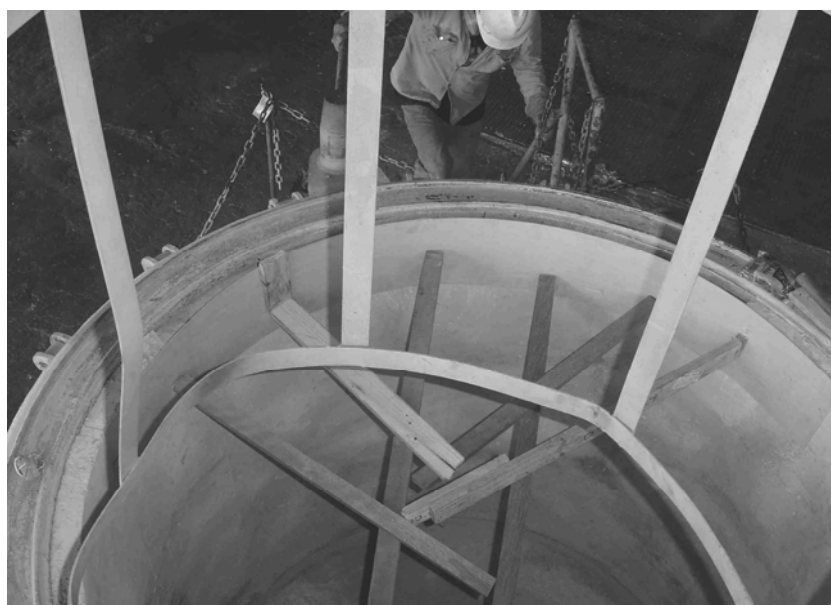
Figura 4.13: Utilização de escada para operador e apoios de madeira para fixação do revestimento.
