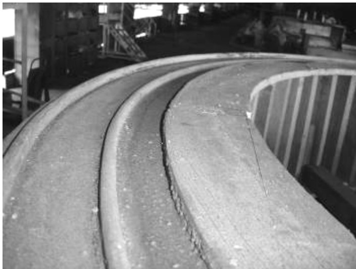
Figura 5.53: Visão superior após o vertimento do concreto ainda no molde de madeira.
