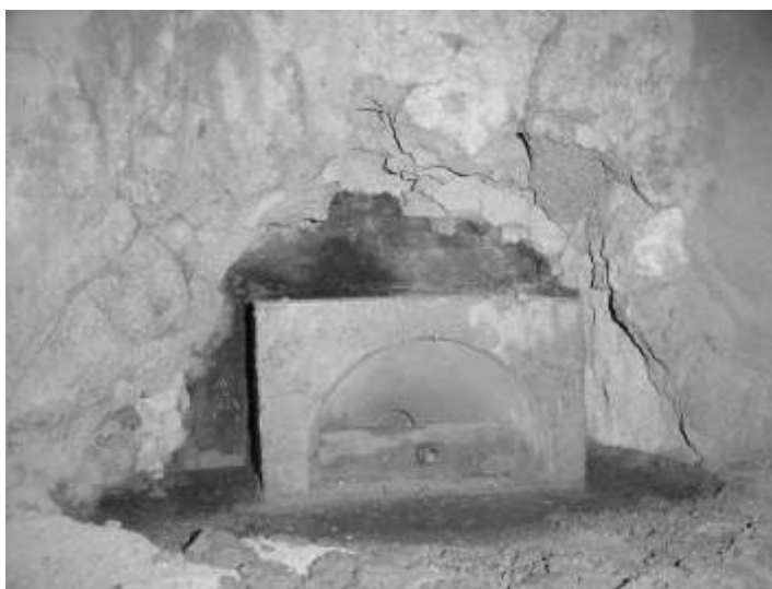
Figura 5.54: Válvula gaveta de refratário denso pré-moldado antes da concretagem.
