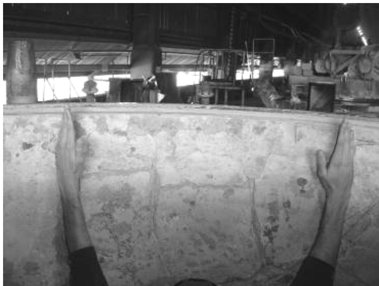
Figura 5.42: Revestimento em bom estado resultante da restauração na manutenção anterior.
