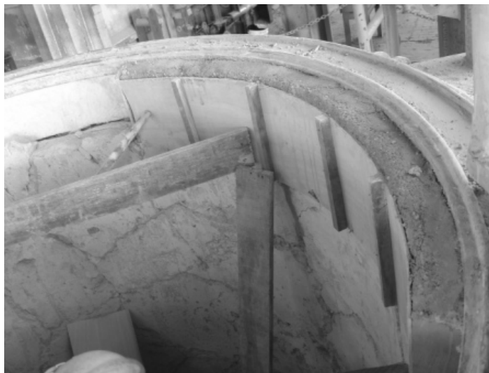
Figura 5.45: Instalação de concreto denso na região de anelar do topo.
