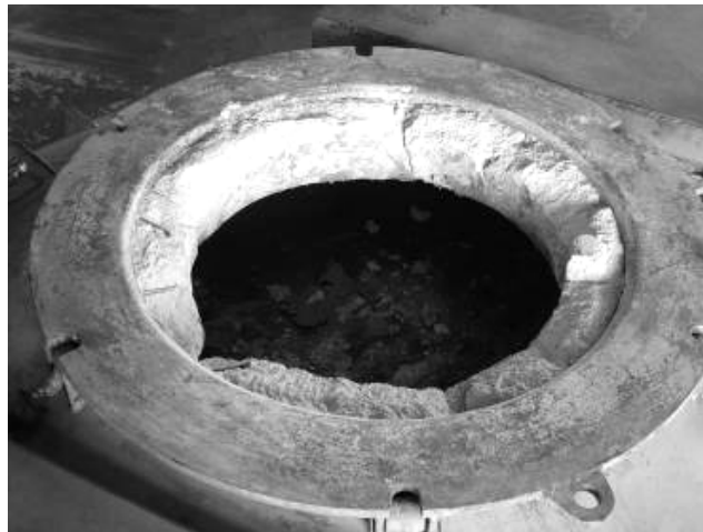
Figura 5.40: Tampa do cadinho. Reparo necessário na porção superior.
