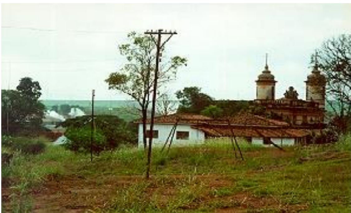
Figura 8 - Edifícios desocupados na Usina Tamoio, Araraquara, SP. Foto: FRANCISCO, J.1996.
