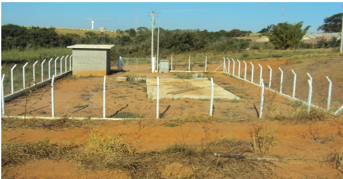
Figura 29 – Casa de contenção do esgoto do Portal Terra da Saúde. Fonte: Autor (2014).
