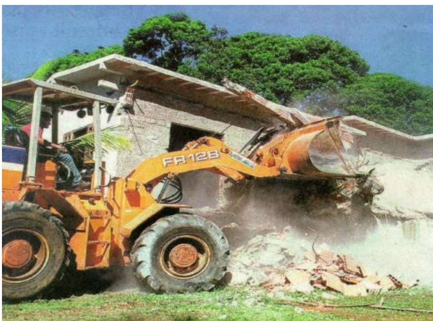
Figura 6 - Demolição. Fonte: ESTADO DE SÃO PAULO, 20 JUL. 2001, p. C6
