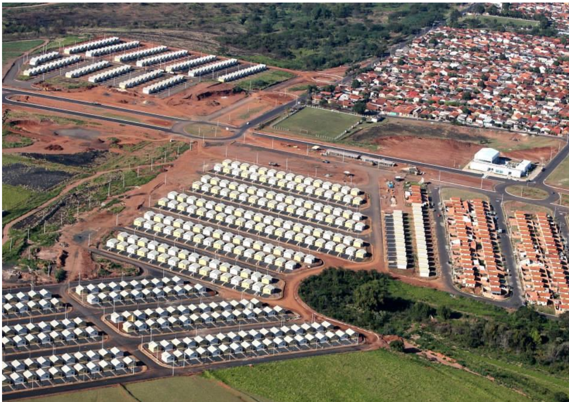
Figura 17 – Portal Terra da Saudade (2013).
