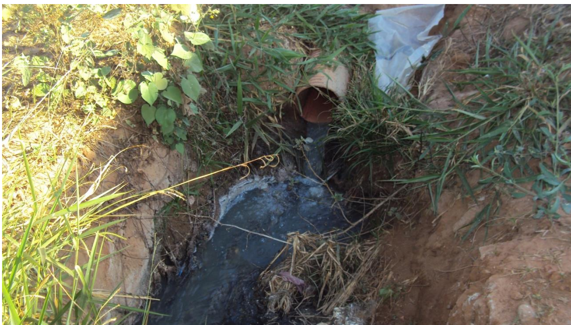
Figura 30 – Lançamento de esgoto no córrego que nascia no Portal Terra da Saudade. Fonte: Autor (2014).
