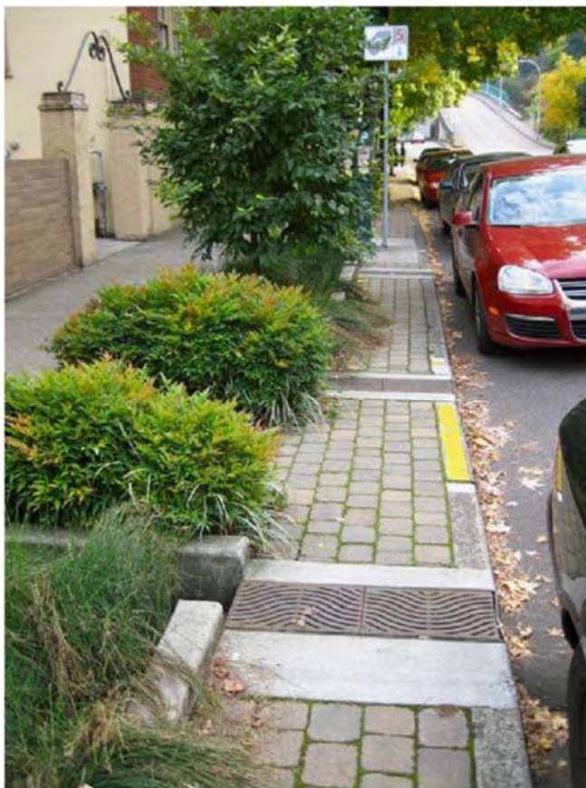
Figura 14 - Jardins de Chuva integrados a blocos permeáveis articulados na cidade de Portland, Estados Unidos
