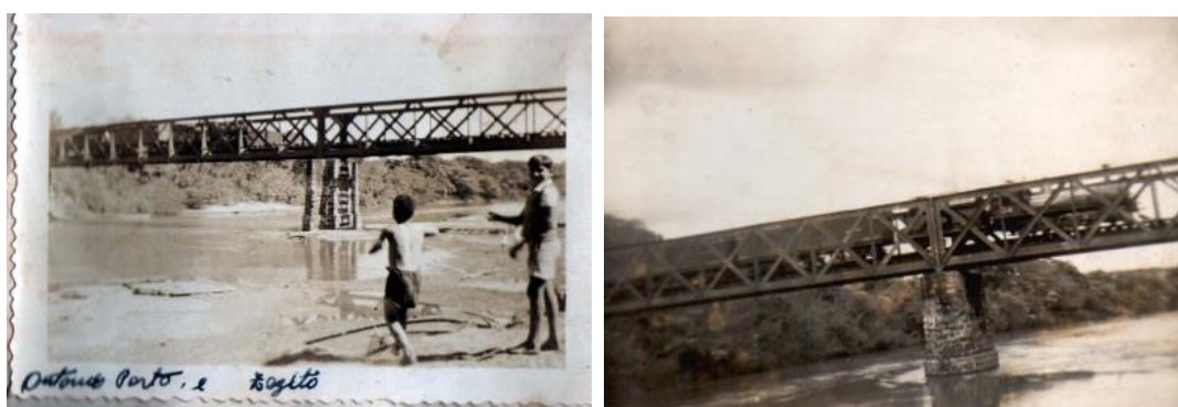
Figura 46: Ponte sobre o Rio Pardo, acesso da ferrovia ao território de Altinópolis. Fonte: acervo particular.
