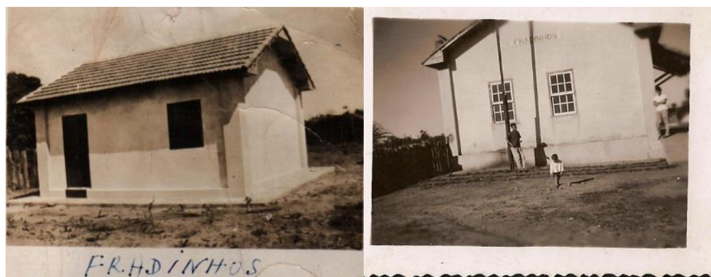
Figura 54: Estação Fradinhos. Fonte: acervo particular.
