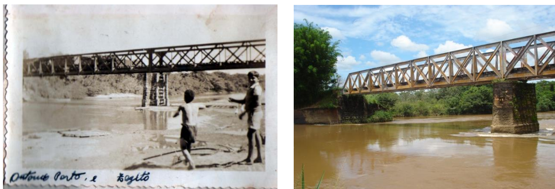
Figura 2: Ponte sobre o Rio Pardo. Estrada de Ferro São Paulo e Minas. Fonte: Núcleo do Centro Histórico de Altinópolis. À direita, imagem da ponte atualmente.
