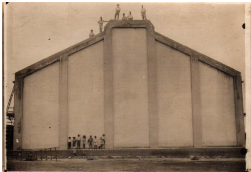
Figura 68: Galpão construído pela São Paulo e Minas, 1936. Fonte: acervo particular.
