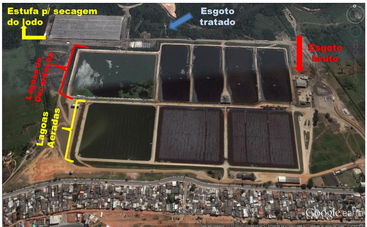
FIGURA 5.3 - Vista aérea da Estação de Tratamento de Esgoto de Jundiaí.
