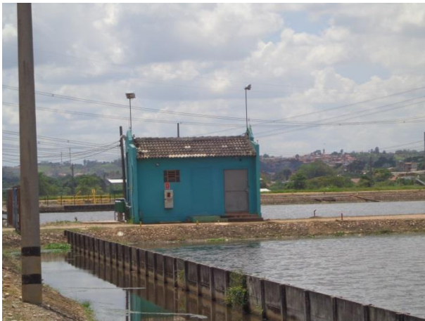
(A) Casa do coletor automático
