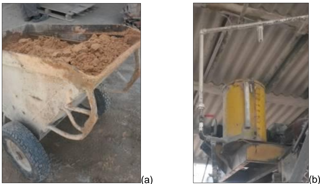
Figura 3.5 (a) Carro de Mão utilizado para dosar agregados, (b) tanque utilizado para controle de água.
