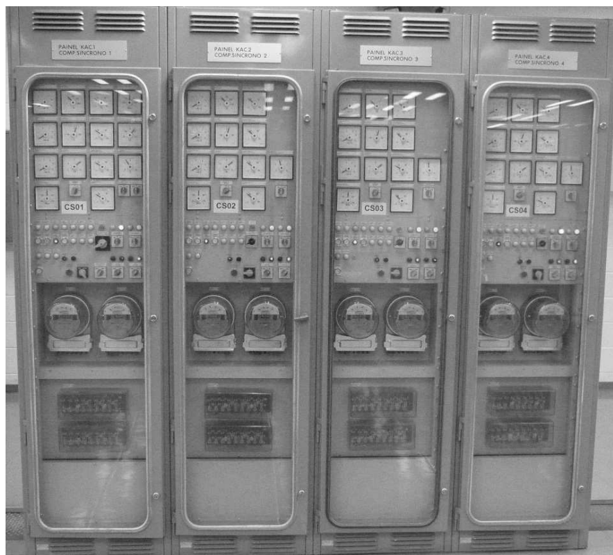
Figura 13 - Painel analógico de comando dos compensadores síncronos
