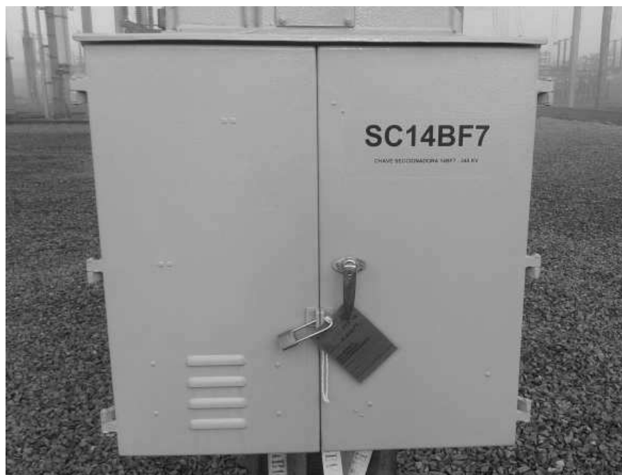
Figura 33 - Cubículo de seccionadora com bloqueio através de cadeado e cartão vermelho
