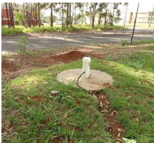
Figura 3.30: Poço de infiltração. Fonte: Ferreira, 2016
