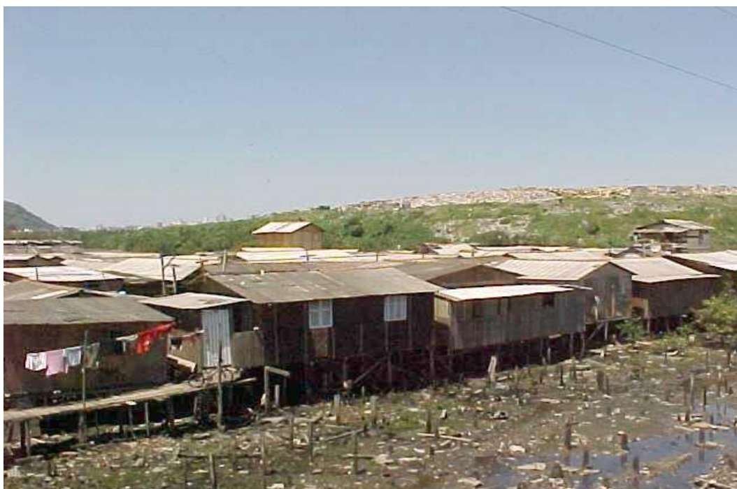
Figura 5.1.13. Palafitas na Favela do Dique da Vila Gilda.
