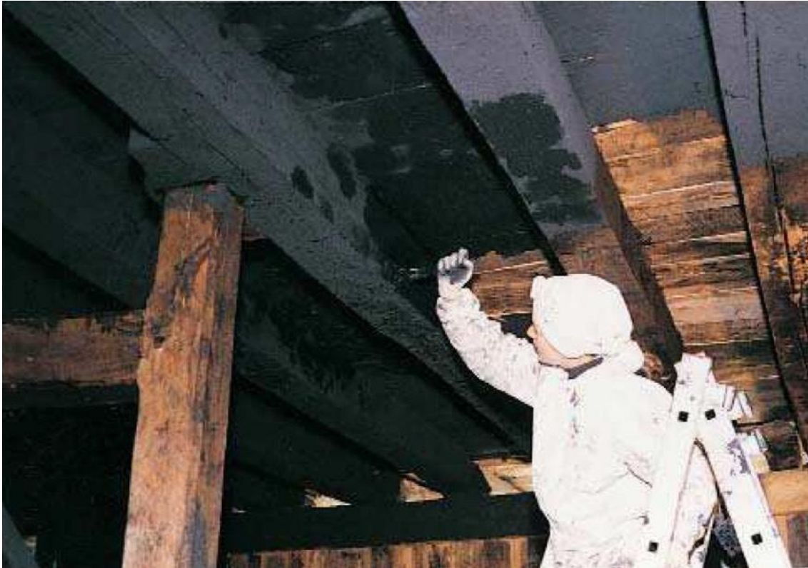
Fig. 1.33. Restauração de Igartubeiti. “Aplicação de uma crosta preta”, de aguaplast misturado com pigmento, que imita a acumulação de vários séculos de fuligem e que esconde a diferença de tonalidade da figura 1.30. Fonte: Santana et al. 2003: 211.
