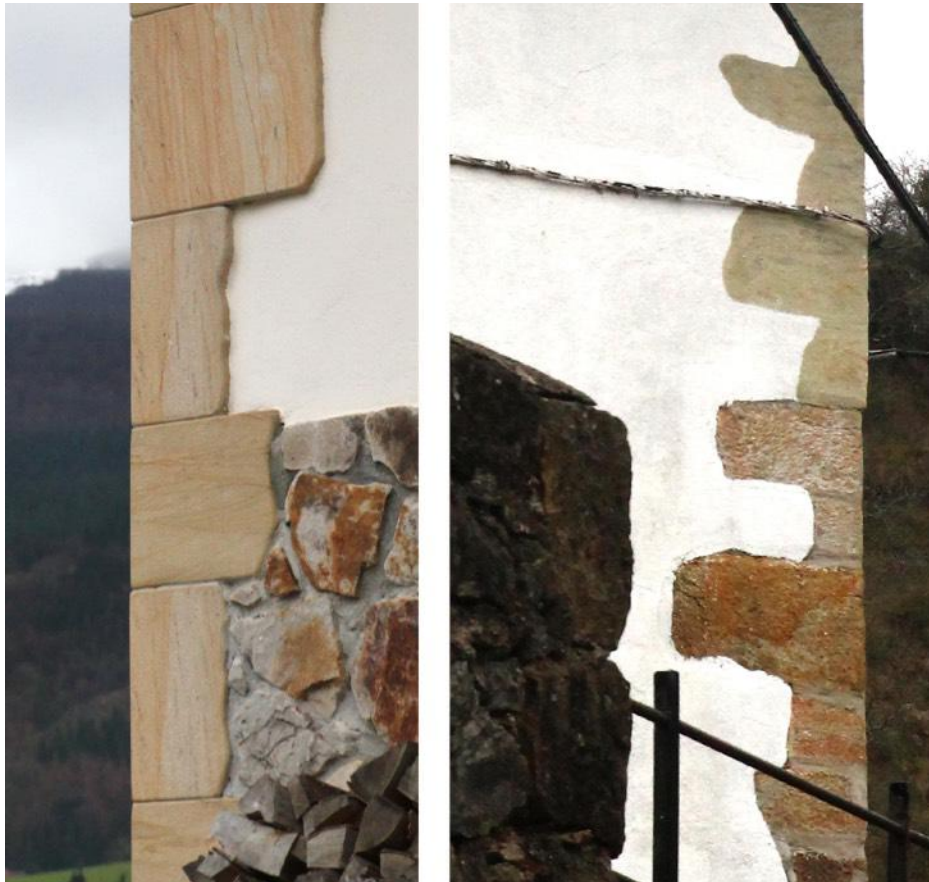
Figs. 2.51 e 2.52. À esquerda, cantoneiras de aplacado de pedra em Txapelena [A57]. À direita cantoneiras originais de pedra de silharia e em cima delas cantoneiras pintadas, no baserri Zumalde [A64].
