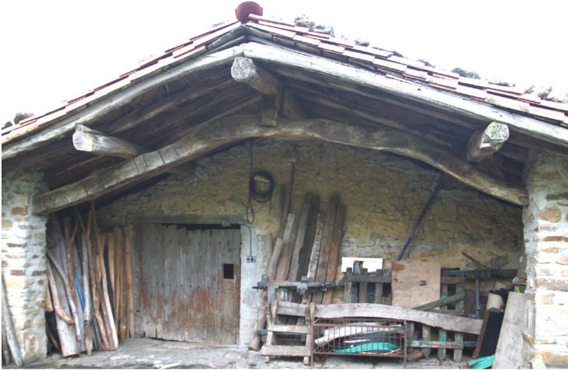
Fig. 2.31. Viga arqueada de castanheiro encontrada e colocada por Juan de Elortondo [A15] no armazém de Erramuena [A17].
