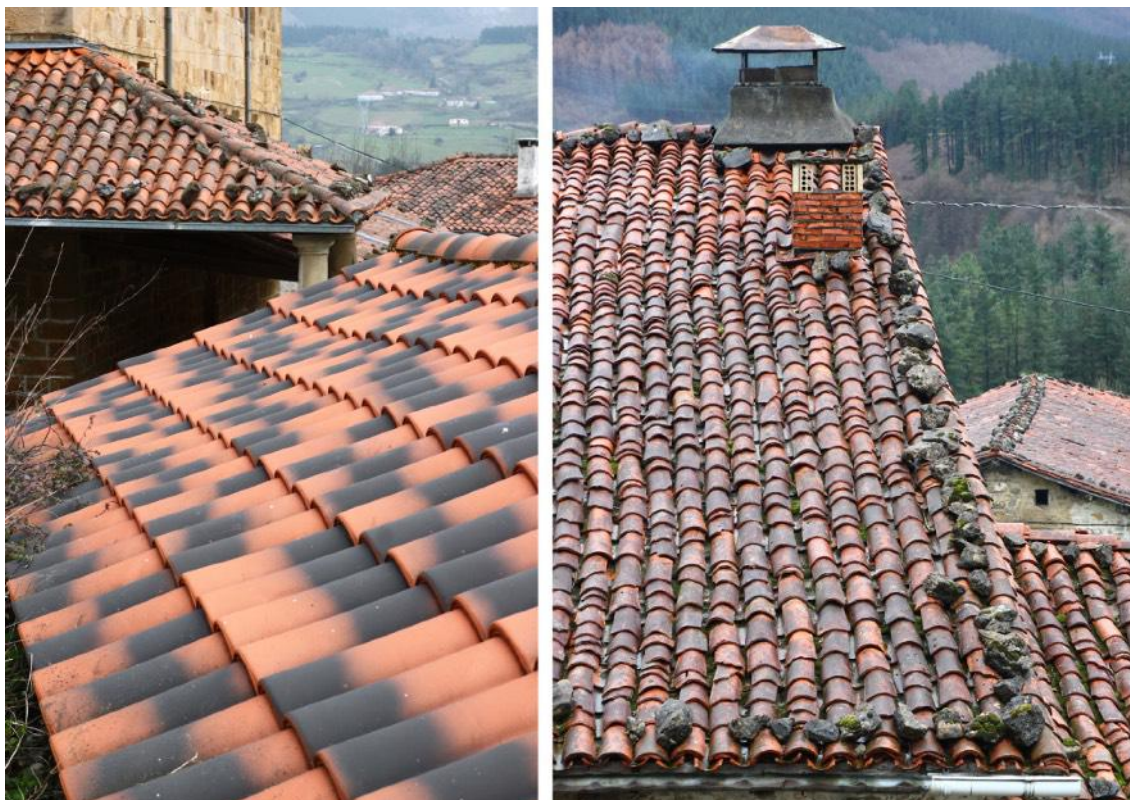
Figs. 2.58 e 2.59. À esquerda, o novo telhado da boleira, frente à igreja de São Miguel [B08]. À direita, o velho telhado do baserri Araotz Urruti Garaikua [A11].
