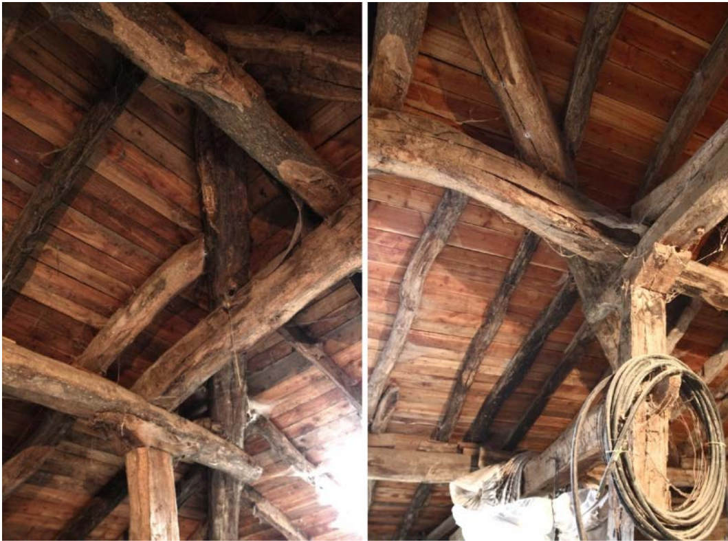
Figs. 2.26 e 2.27. Encontros entre vigas estruturais no telhado do baserri Emparantza [A16]. Note-se como são os detalhes construtivos os que se adaptam ao aproveitamento de determinadas madeiras, e não ao contrário.
