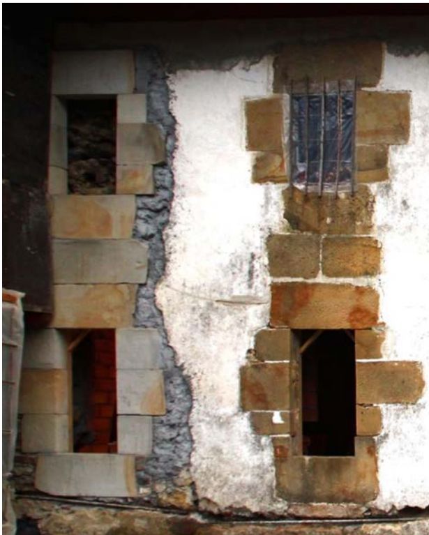
Figs. 2.47 e 2.48. Janelas de Errastikua [A19] abertas por Benjamín e Jaime, ainda em construção. À esquerda pode se perceber a diferença entre as janelas velhas e as novas.
