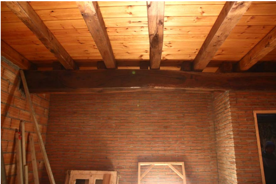
Fig. 2.23. Vigas da cozinha de Errastikua [A19] restauradas por Benjamín e seus irmãos. A viga comentada é a segunda começando pela direita.
