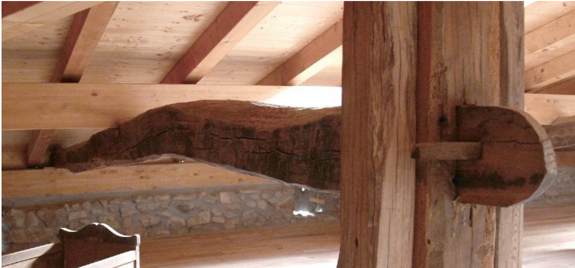
Figs. 2.29. Contraste entre a irregularidade de uma viga reciclada de madeira carvalho e a regularidade do travessamento de madeira de pinheiro industrializada; em Errastikua [A19].
