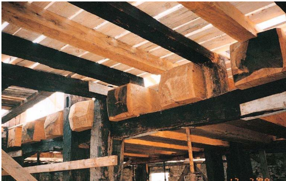
Fig. 1.32. Restauração de Igartubeiti. Contraste de cor entre as vigas novas (incorporadas na restauração) e as velhas. Fonte: Santana et al. 2003: 199.
