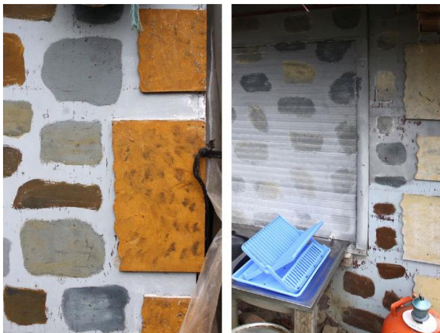
Figs. 2.55, 2.56 e 2.57. Txabola de Antonio [B09]. Note-se que a pintura das paredes, construídas com chapa de compensado, procura imitar a construção de pedra de mampostaria e de silharia própria do baserri-arquitetura . As cantoneiras são chapas de compensado recortadas irregularmente e pintadas de amarelo (com manchas em marrom representando sujeira). A fotografia abaixo à direita mostra como a pintura das pedras supera o paramento sólido e se estende pela superfície de uma persiana.
