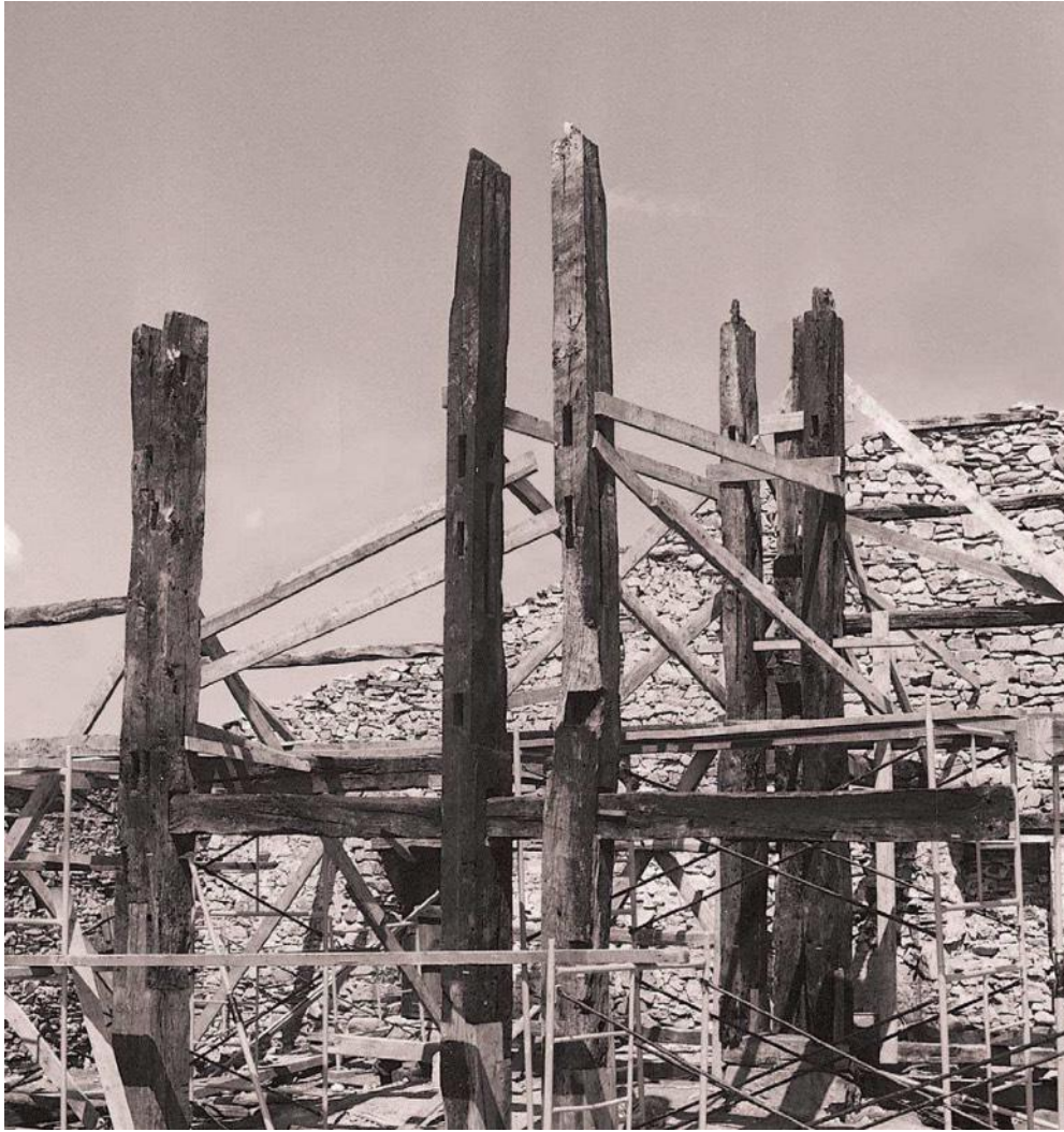
Fig. 1.31. Restauração de Igartubeiti. Processo de “desmontagem”. Fonte: Santana et al. 2003: 197.
