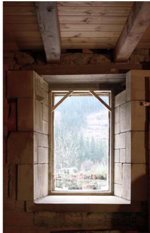
Figs. 2.47 e 2.48. Janelas de Errastikua [A19] abertas por Benjamín e Jaime, ainda em construção. À esquerda pode se perceber a diferença entre as janelas velhas e as novas.
