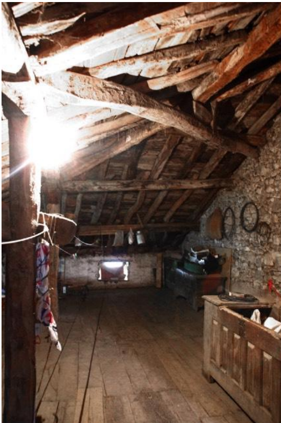
Figs. 0.15 e 0.16. Estrutura da cobertura de Aitzkorbe Azpikua [A05] na atualidade. À esquerda a metade que sobreviveu às chamas, à direita a metade reconstruída depois do incêndio.
