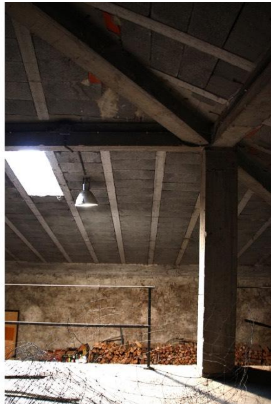
Figs. 0.15 e 0.16. Estrutura da cobertura de Aitzkorbe Azpikua [A05] na atualidade. À esquerda a metade que sobreviveu às chamas, à direita a metade reconstruída depois do incêndio.
