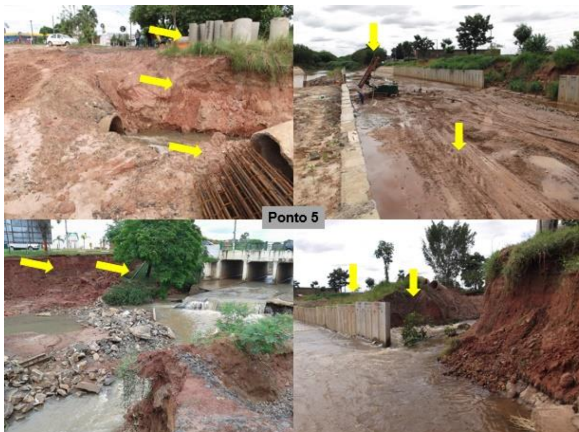
Figura 17. Obras de retificação e canalização, retirada de solo e árvores são algumas das ações antrópicas acometidas no Ribeirão das Furnas.
