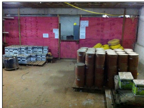
Figura 74 - Estoque de tintas no subsolo – Empresa D
