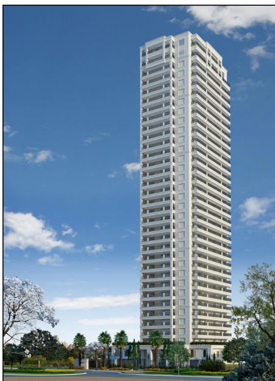
Figura 67 - Edifício residencial – Empresa D
