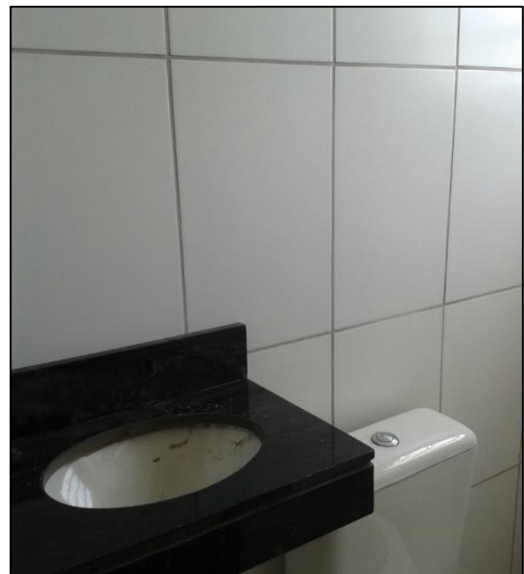
Figura 35 - Banheiro com personalização em granito tipo 2 e revestimento até o teto – Empresa A
