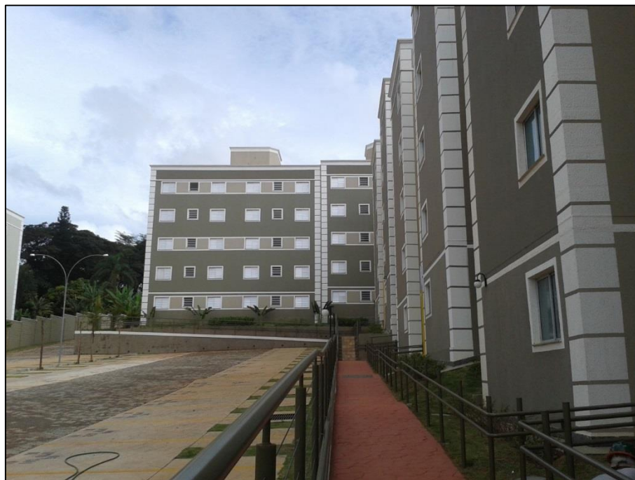
Figura 13 - Fachada da obra – Empresa A
