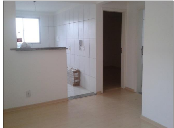
Figura 27 - Apartamento com personalização em piso laminado – Empresa A
