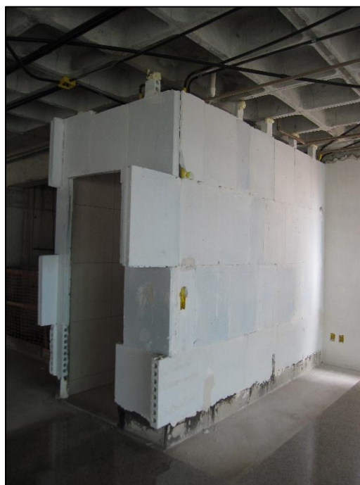
Figura 55 - Divisórias em blocos de gesso – Empresa C
