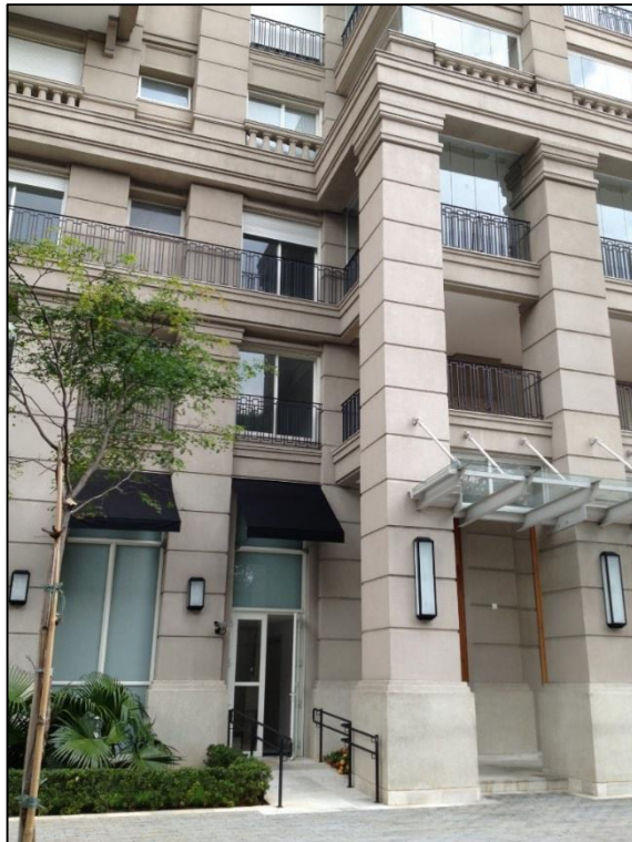
Figura 45 - Térreo do edifício – Empresa B
