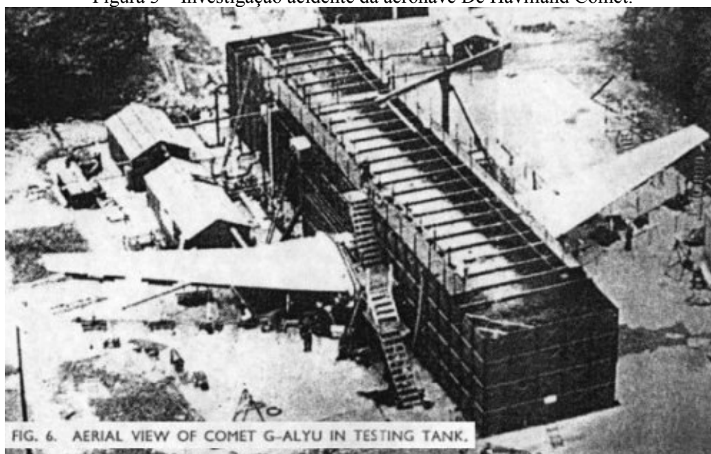
Figura 3 – Investigação acidente da aeronave De Havilland Comet.
