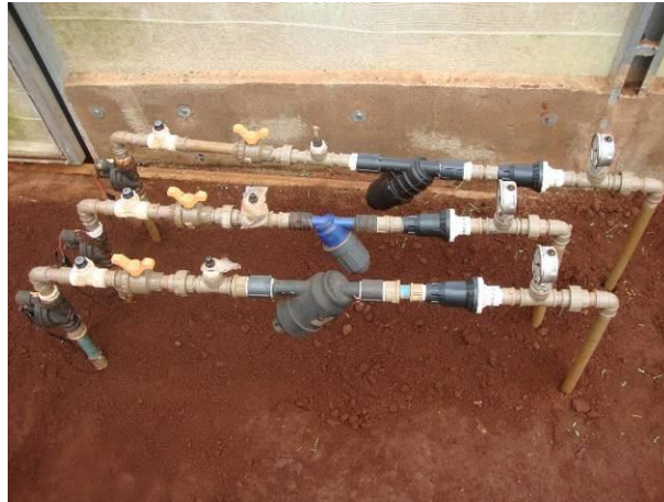
Figura 3 – Cabeçal de controle da linha de irrigação de cada tratamento, compostos por (da esquerda para a direita) solenoide, válvula antivácuo, registro de esfera, injetor, filtro de disco, regulador de pressão e manômetro.
