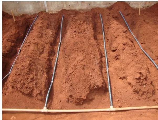
Figura 2 – Linhas de gotejadores instaladas a 0,20 m de profundidade em valetas abertas nos canteiros.
