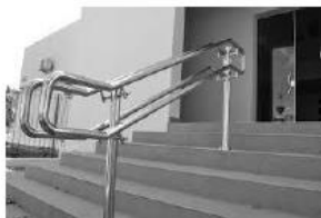
LANCE DE ESCADA
