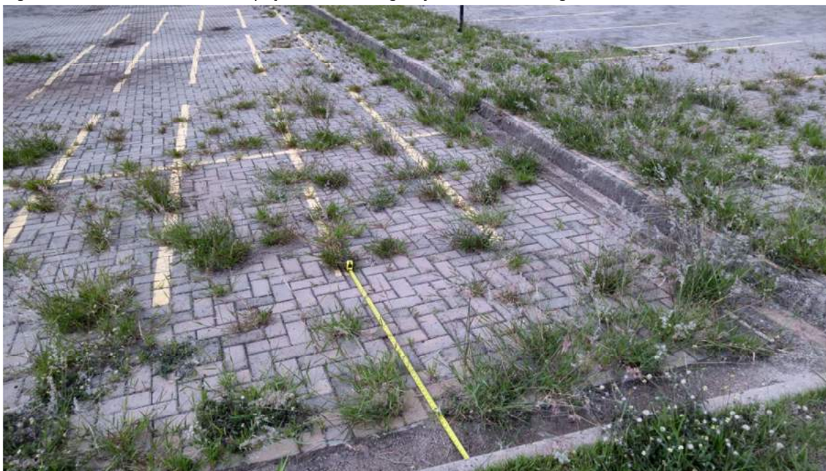
Figura 59 – Estacionamento do Espaço Cultural – Vegetação na área das vagas.
