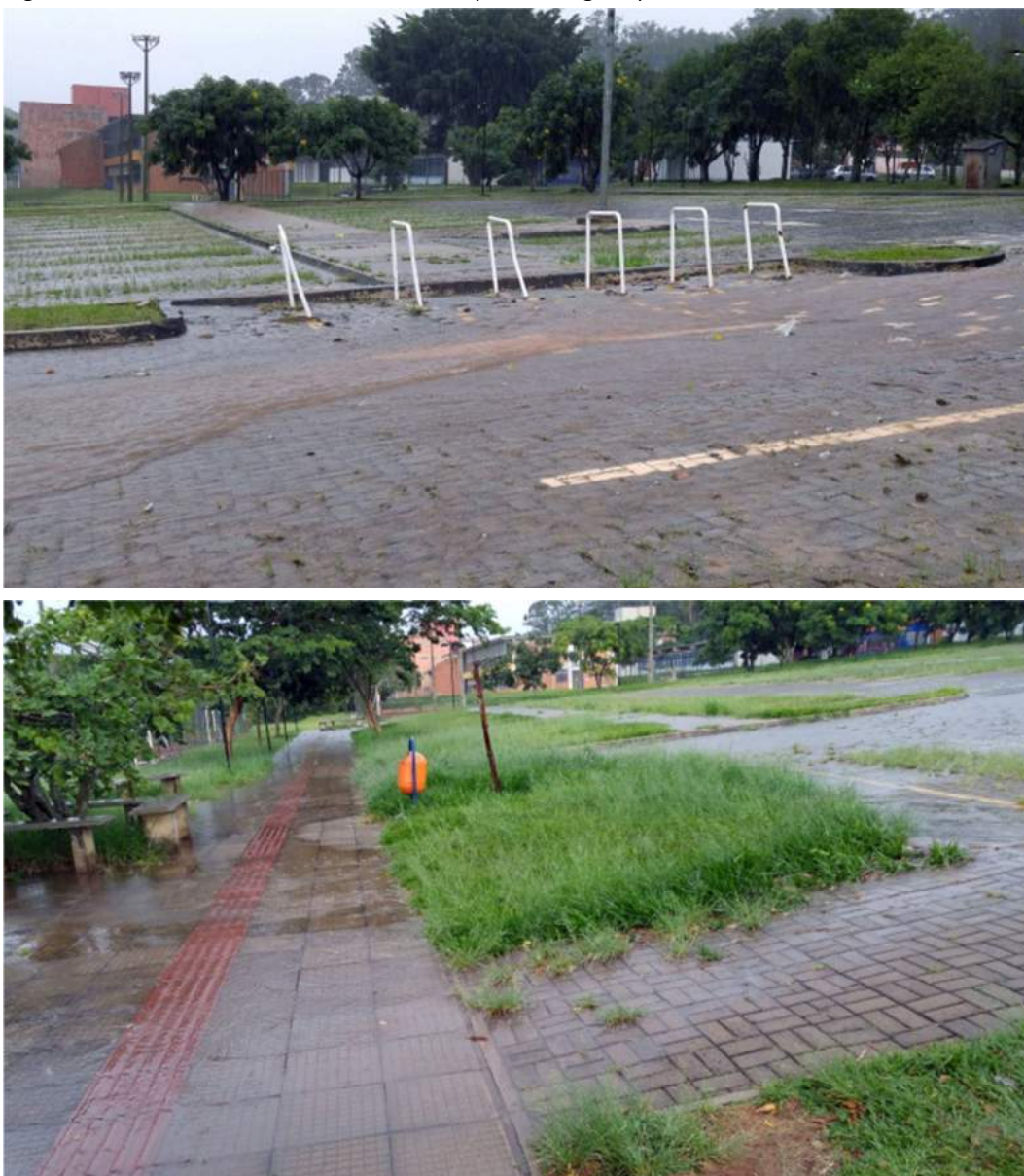
Figura 53 – Estacionamento do Ginásio de Esportes – Águas pluviais.
