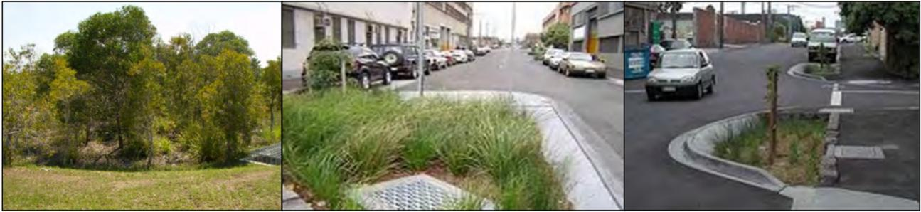
**Figura 15:** Exemplos australianos de sistemas de biorretenção. Fonte: JSCWSC, 2009.
