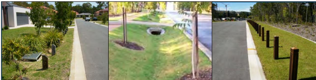
**Figura 12:** Exemplos australianos de implantação de Swales e Buffer Strips. Fonte: JCSWSC, 2009.
