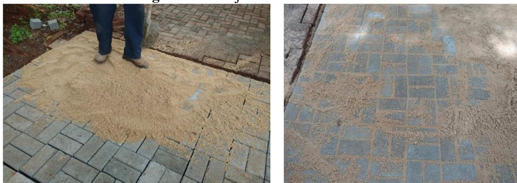
Para terminar a execução da calçada foram executados os arremates em torno de uma caixa existente , Figura 56 (B), e também no encontro com a calçada existente. Para finalizar foi realizada a contenção lateral evitando assim o deslocamento da lateral livre da calçada, Figura 56 (A) essa contenção foi executada com concreto magro e auxílio de formas.
