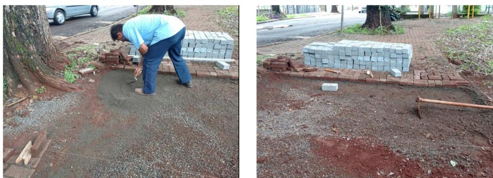
Terminada a camada de assentamento foi dado início ao assentamento das peças, obedecendo o esquadro e nível determinado. O paginação seguiu o modelo tipo trama, com a
