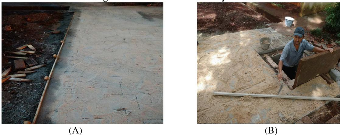
Logo após a execução da calçada protótipo foi realizada uma inspeção visual verificando detalhes como: espaçamento entre as juntas, intertravamento das peças, aspecto geral da calçada, diferenças de coloração, acabamento das contenção lateral e dos arremates. A Figura 57 traz o aspecto da calçada terminada.
