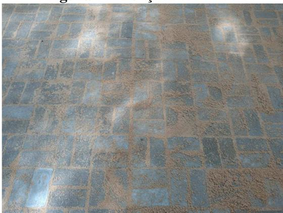
De maneira geral a execução ficou a contento, sendo que apenas um único detalhe chamou atenção: uma pequena diferença de coloração entre as peças com e sem resíduos, como pode ser visto na Figura 58.
