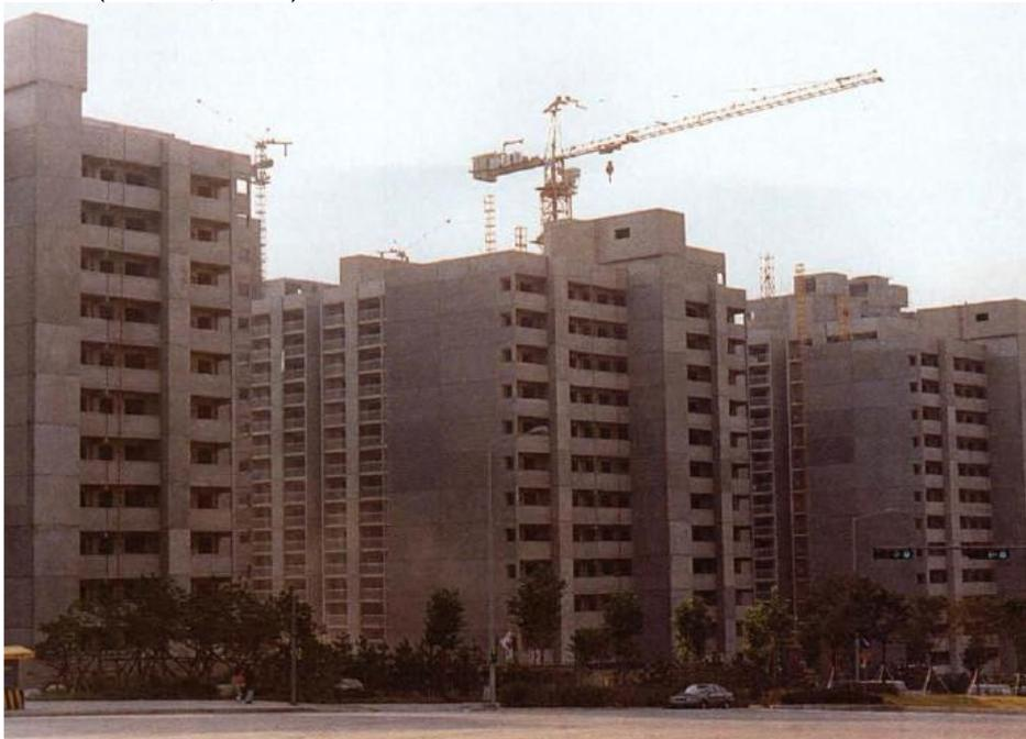
Os painéis são utilizados para fechamentos internos e externos, caixas de elevadores, núcleos centrais etc. Assim, esta modalidade de pré-fabricação é considerada como a solução para substituição de paredes moldadas no local, como tijolos convencionais e alvenaria. Têm ainda a vantagem de serem prontos para receber acabamento em pintura ou papel de parede, rapidez na construção, isolamento acústico e resistência ao fogo entre outros (FIB, 2002).
