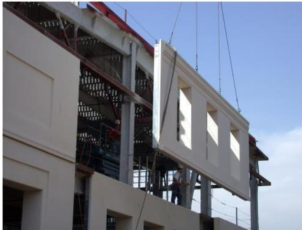
**Figura 4** - Montagem e escoramento de painéis pré-moldados tipo tilt-up.
