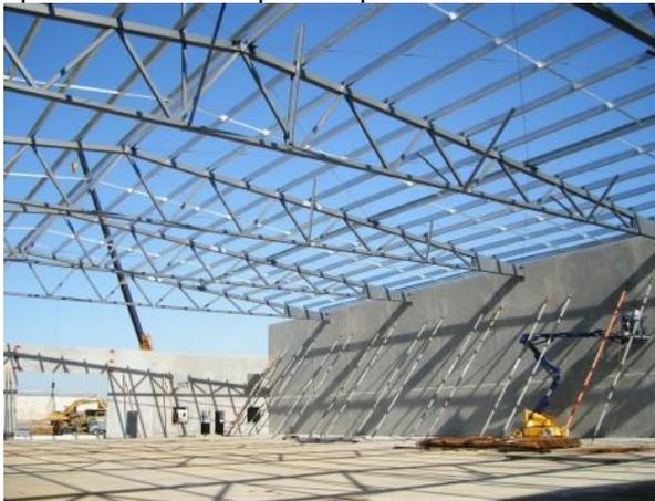
**Figura 2** - Pórtico atirantado em esqueleto, com fechamento em painéis pré-moldados.
