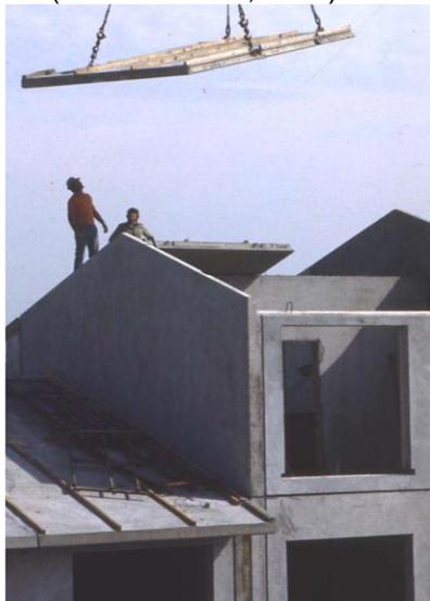
Os painéis de parede pré-moldados estruturais fazem parte da estrutura da edificação, funcionando como elementos que resistem aos esforços locais, ou seja, referentes ao elemento de forma isolada, bem como esforços globais advindos da estrutura através de ligações com outros elementos estruturais adjacentes. (Projeto de norma ABNT NBR 16.675 (2016)).
