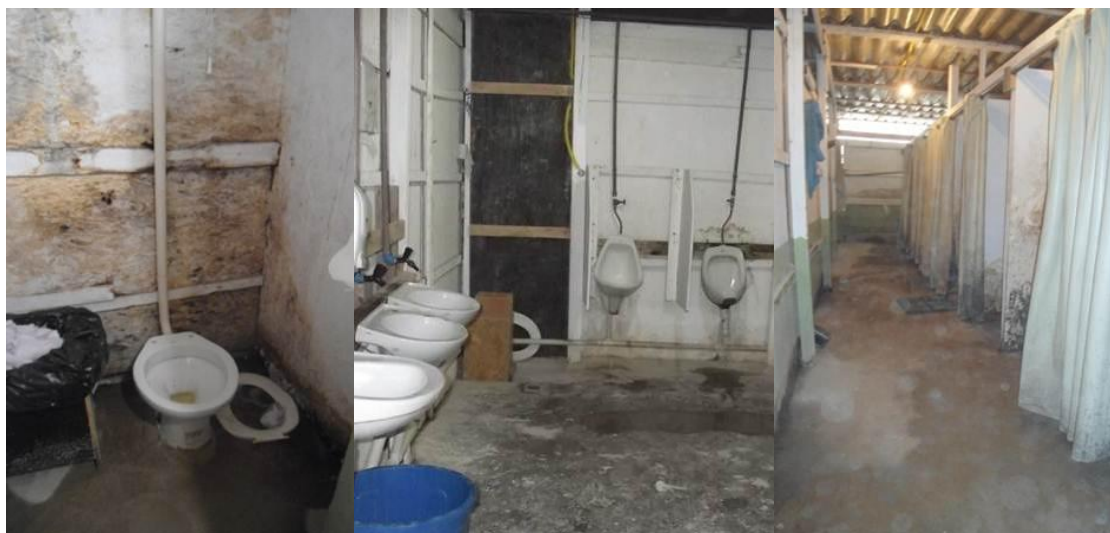
Figura 15: Banheiros de obras antigas da empresa
