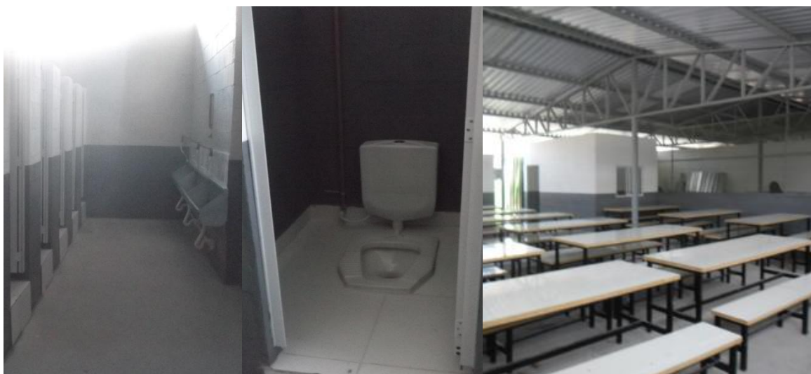
Figura 16: Banheiros e refeitório residencial Vera cruz
