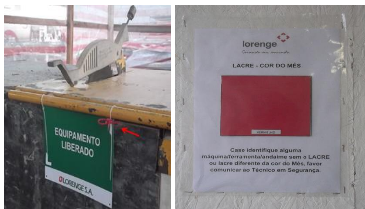
Figura 27: Exemplo de inspeções de máquinas e equipamentos
