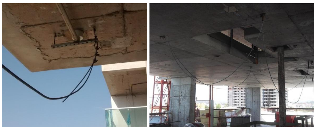
Figura 25: Esperas na laje para instalação da linha de vida
