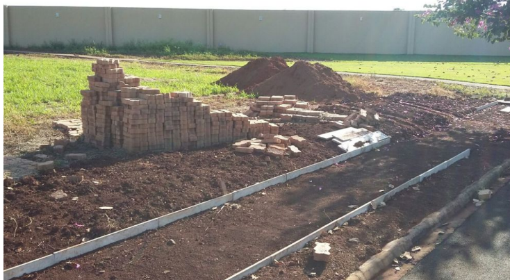
Figura 24 - Entulho moído para base de calçada e bloco Intertravado.
