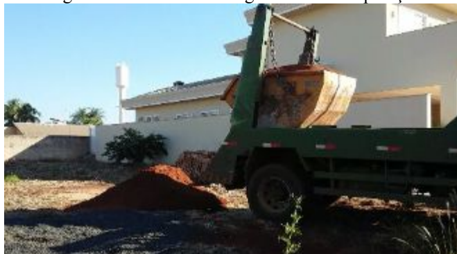
Figura 13 - Caminhão Poliguindastes em operação
