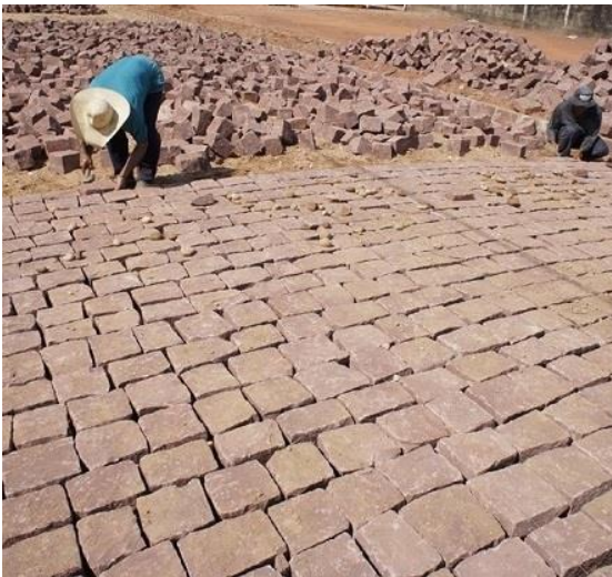
Figura 2 - Execução do pavimento com paralelepípedos
