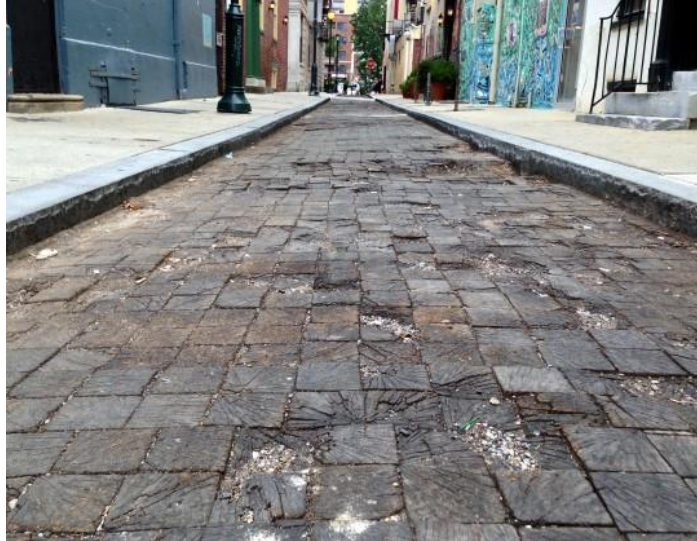
Figura 4 - Pavimento revestido com peças de madeira
