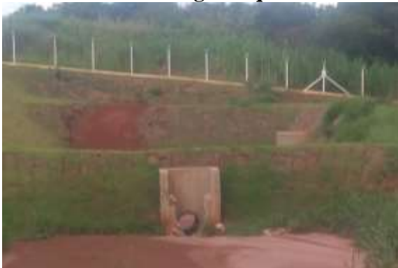
Figura 80 – Orifício de saída acoplado ao vertedor triangular quebrado
