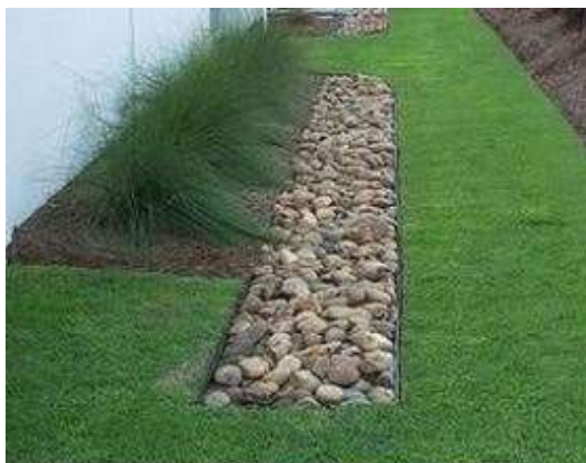
Figura 7 – Trincheira de infiltração
