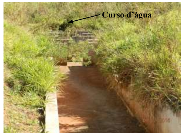
Figura 93 – Dispositivo de lançamento na margem – Tipo C – Vista 2
