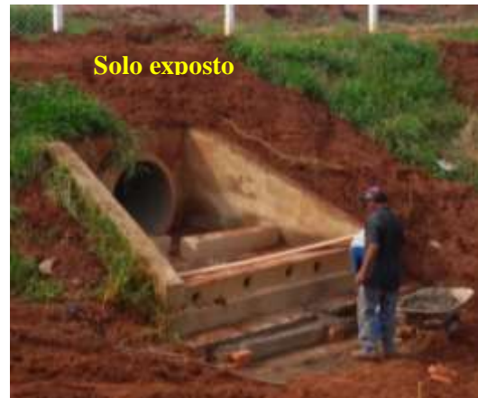
Figura 85 – Estrutura de entrada – Tipo D
