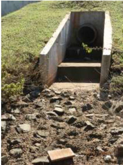
Figura 90 – Dispositivo de lançamento na margem – Tipo A
