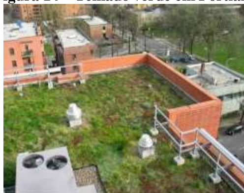
Figura 14 – Telhado verde em Portland
