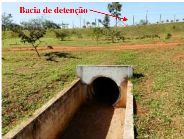
Figura 92 – Dispositivo de lançamento na margem – Tipo C – Vista 1
