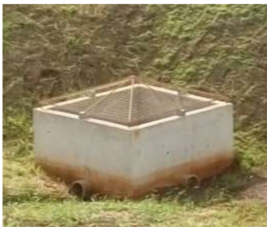
Figura 86 – Estrutura de saída – Tipo A
