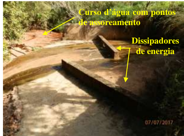
Figura 91 – Dispositivo de lançamento no leito – Tipo B
