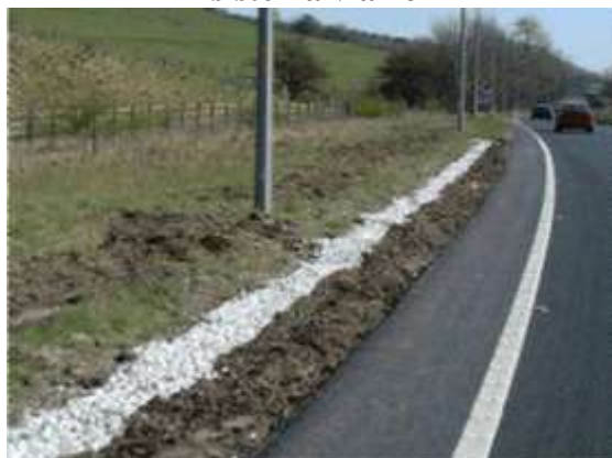
Figura 8 – Trincheira ao longo do sistema viário
