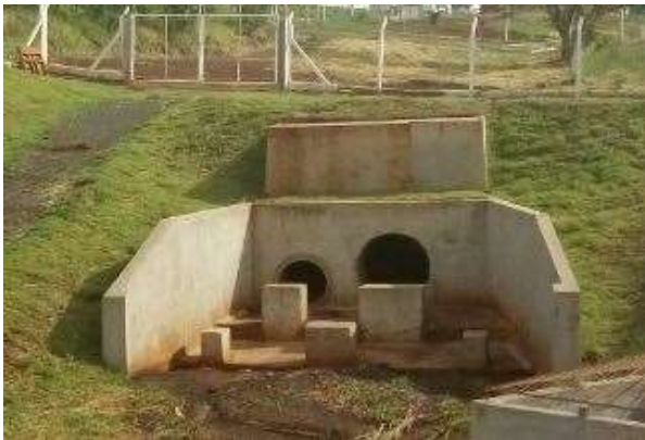
Figura 84 – Estrutura de entrada – Tipo C
