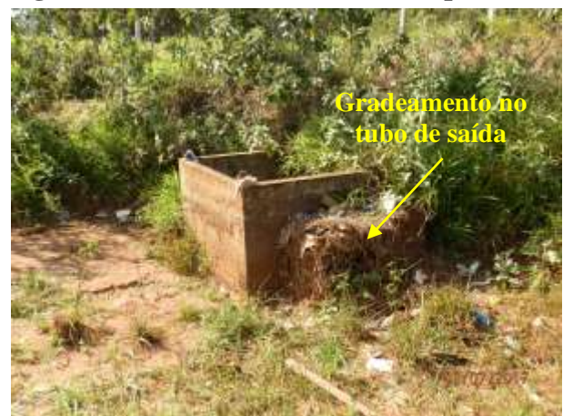
Figura 87 – Estrutura de saída – Tipo B
