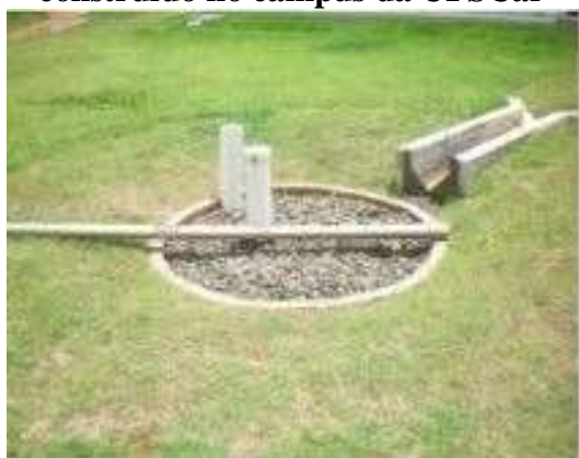
Figura 12 – Poço de infiltração construído no campus da UFSCar
