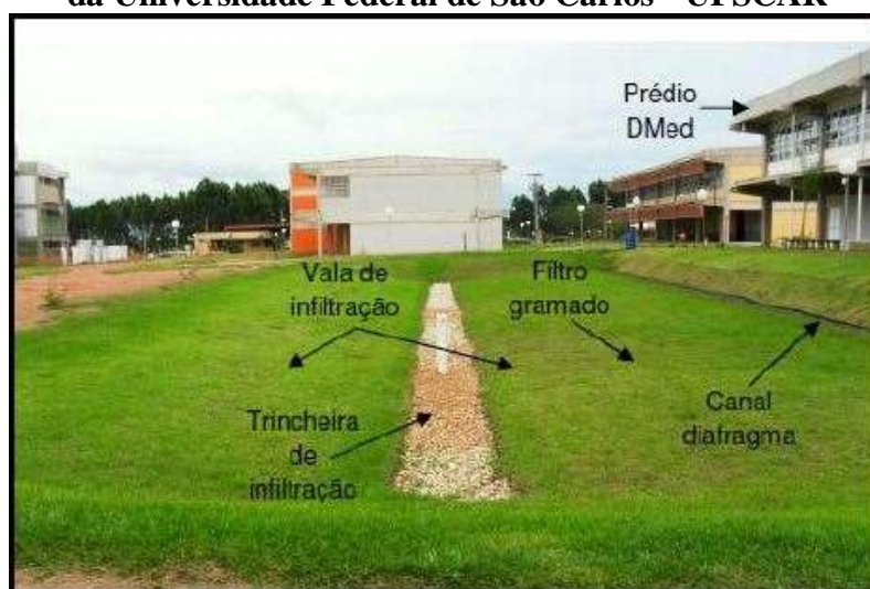
Figura 9 – Sistema Filtro–Vala–Trincheira de infiltração construído no campus da Universidade Federal de São Carlos - UFSCAR
