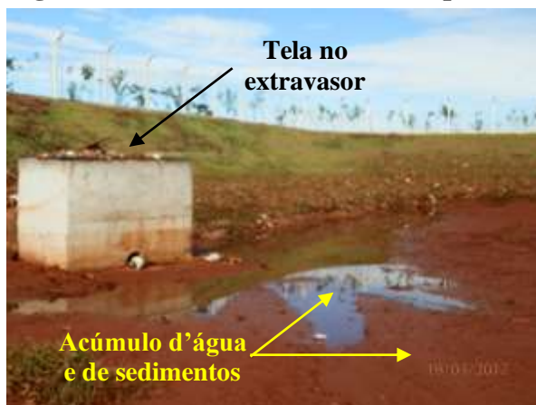
Figura 88 – Estrutura de saída – Tipo C
