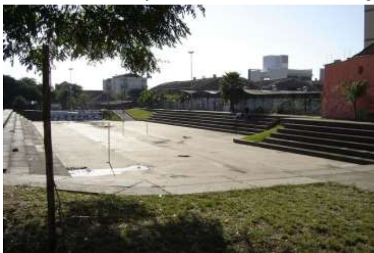
Figura 6 – Bacia de detenção seca e multiuso, em Porto Alegre/RS
