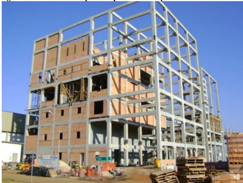
Figura 1.3 – Estrutura de pórticos pré-moldados preenchidos com alvenaria
