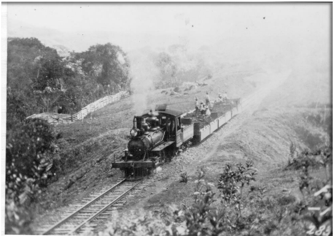
Figura 1. Ferrovia do Pacifico. Paso do trem no caminho férreo Cali - Popayán.
