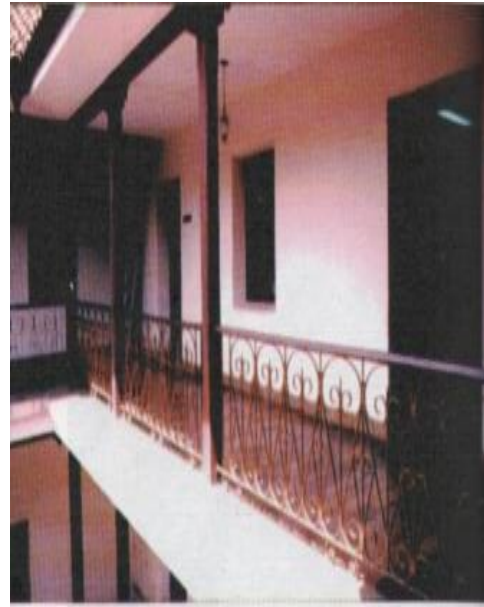
Figura 9. Grades e balaústres de ferro Fonte: Velasco (2004)
