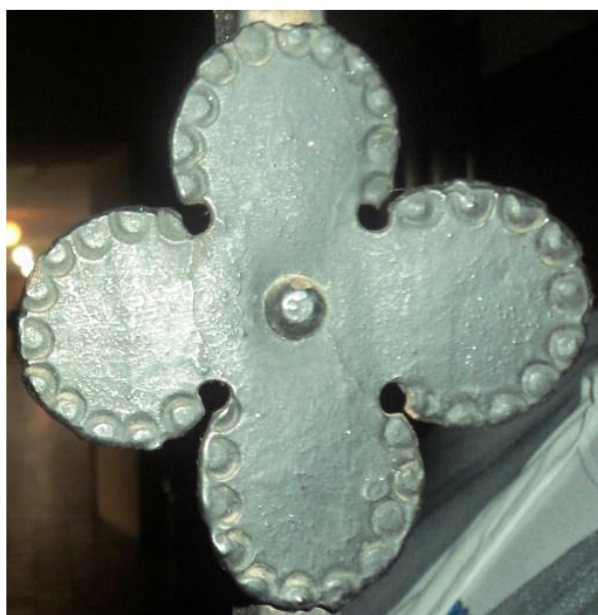
Figura 80. Técnica de ferraria clássica. Rebite (remache).
