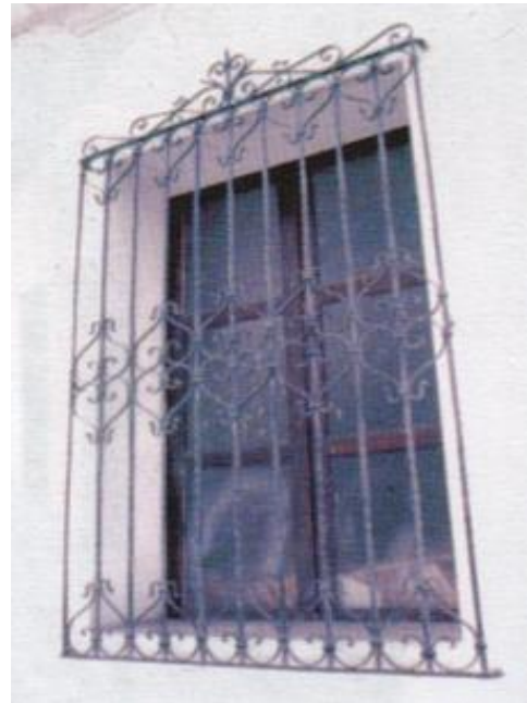
Figura 5. Grades de ferro forjado Fonte: Velasco (2004)
