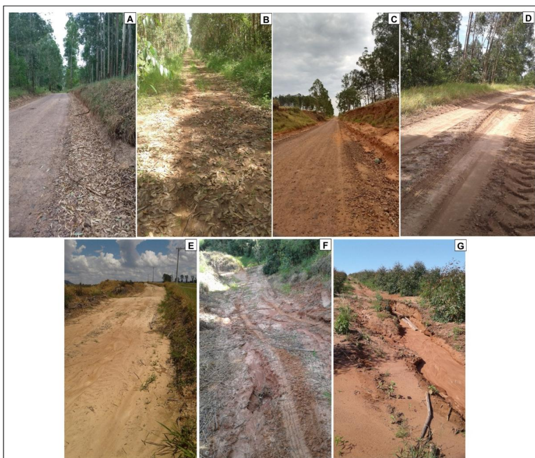
Figura 8- Estradas florestais classificadas em níveis de criticidade: (A) extremamente baixa; (B) muito baixa; (C) baixa; (D) média; (E) alta; (F) muito alta e (G) extremamente alta; da fazenda Santa Terezinha no município de Bofete, estado de São Paulo.
