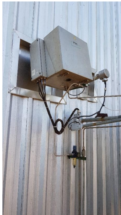
Figura 15. Sondas Uras26 (à esq.) e AZ20 (à dir.) para análise de CO e O_2 , respectivamente. Fonte: acervo pessoal.
