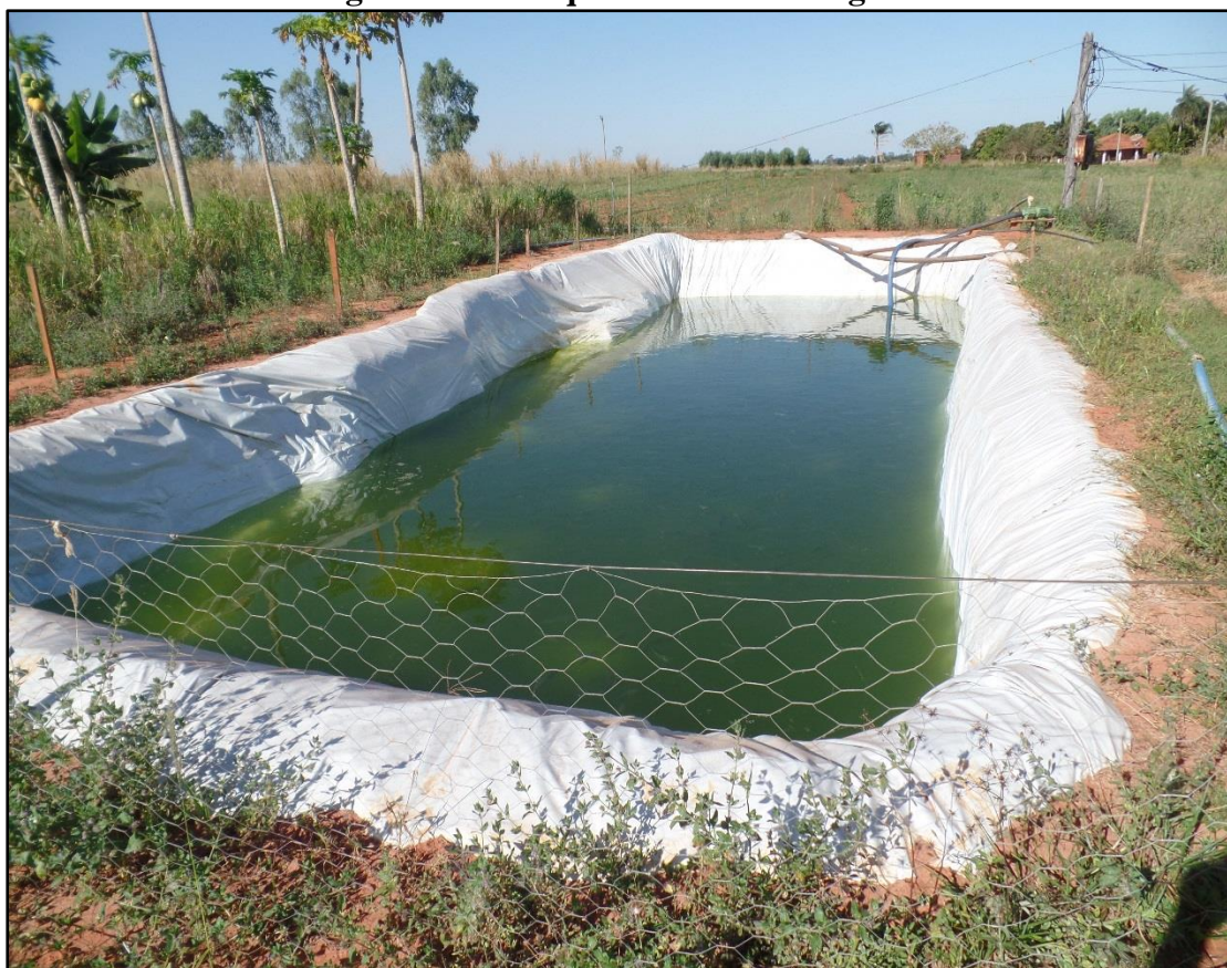
Figura 13 – Tanque de reserva de água
