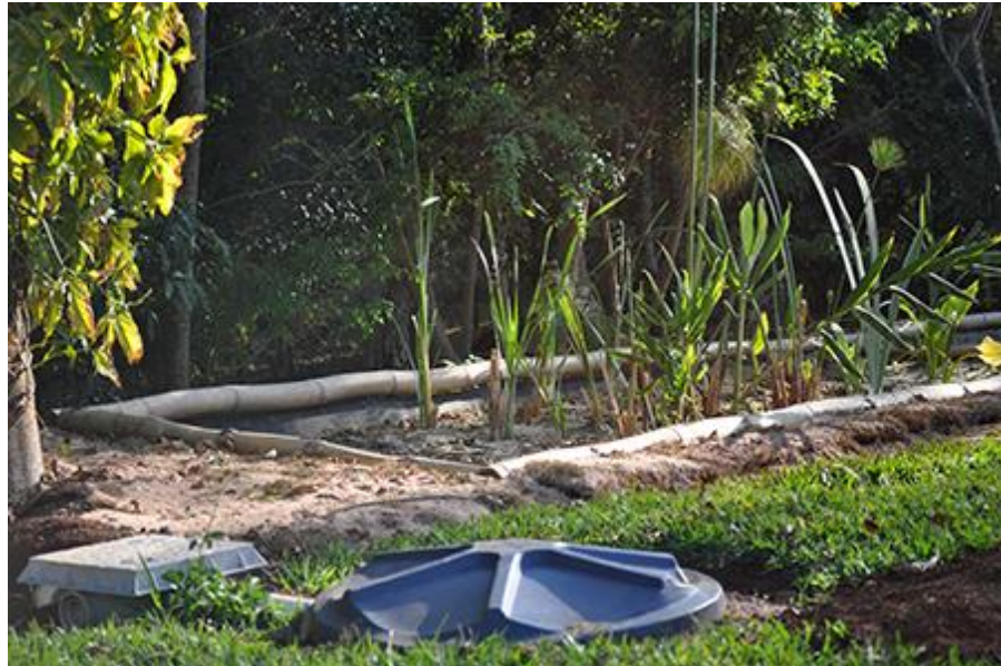
Figura 5: Jardim Flutuante e Cisterna no Assentamento Santa Helena
