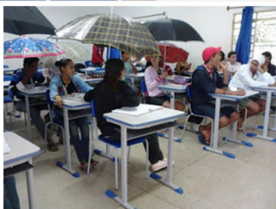
Escolas brasileiras sofrem de diversos problemas estruturais, como goteiras e condenações estruturais. Imagem: CircuitoMT
