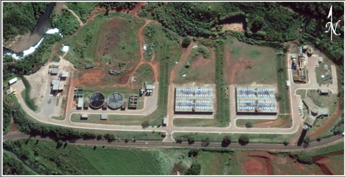
Figura 16. Estação de tratamento de esgoto Monjolinho (ETE-Monjolinho)
