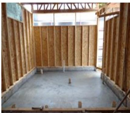
**Figura 2 - Instalação provisória em sistema pré-fabricado em madeira, dois pavimentos**
