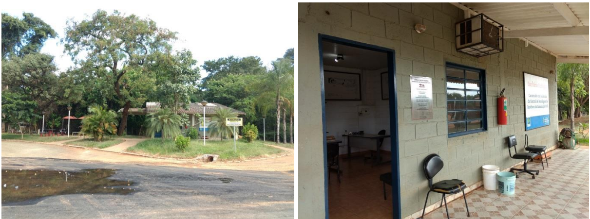
Figuras 10 e 11 - Edificação de apoio da usina de reciclagem de RCC de SJRP.
