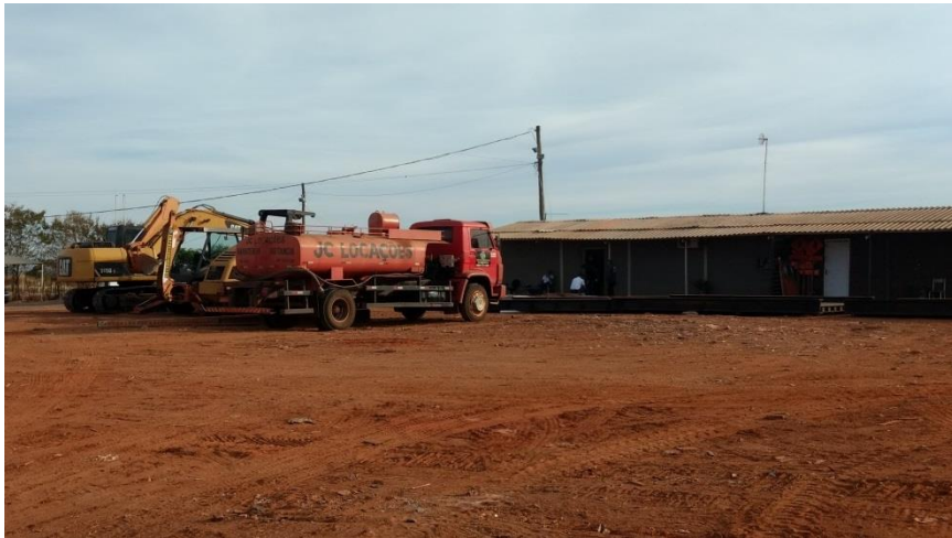
Figuras 39 - Edificação de apoio da usina de reciclagem de RCC de Bady Bassitt.
