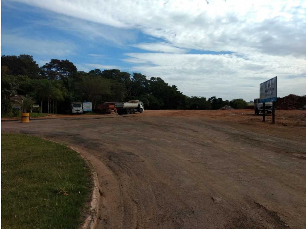
Figura 32 - Local de passagem dos caminhões da usina de reciclagem de RCC de SJRP.
