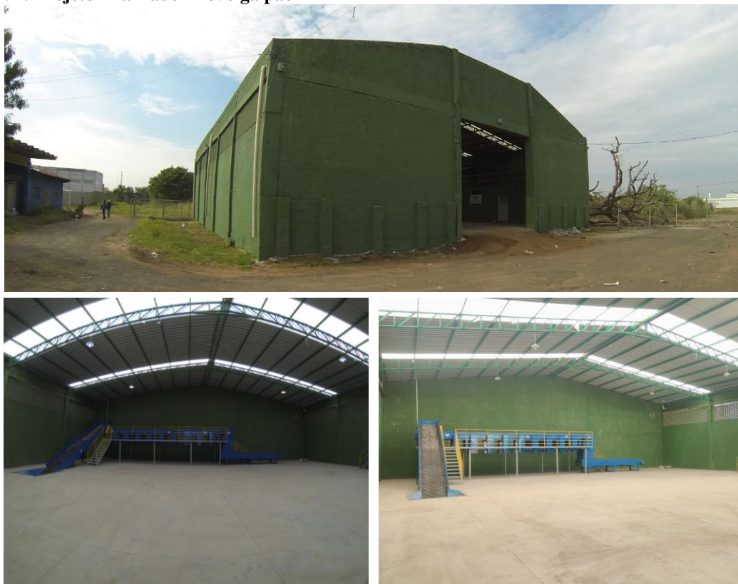
Figura 51: Projeto finalizado - novo galpão
