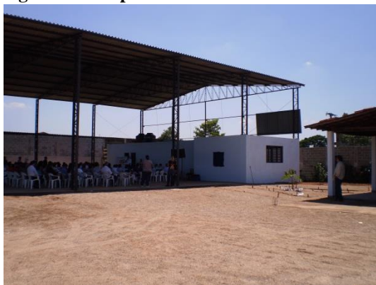
Figura 40: Galpão localizado no Distrito Industrial
