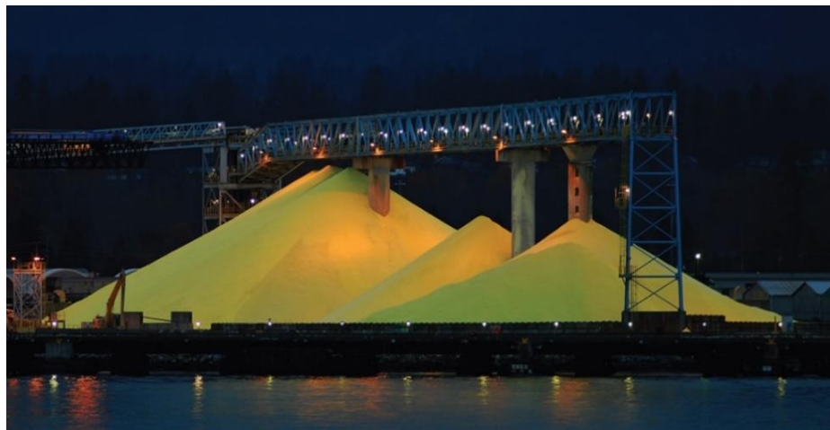
FIGURA 2.3 – Depósitos de enxofre elementar obtidos por hidrodessulfurização do petróleo. Fonte: WORTHINGTON; KUCERA; CHALKER, 2017.
